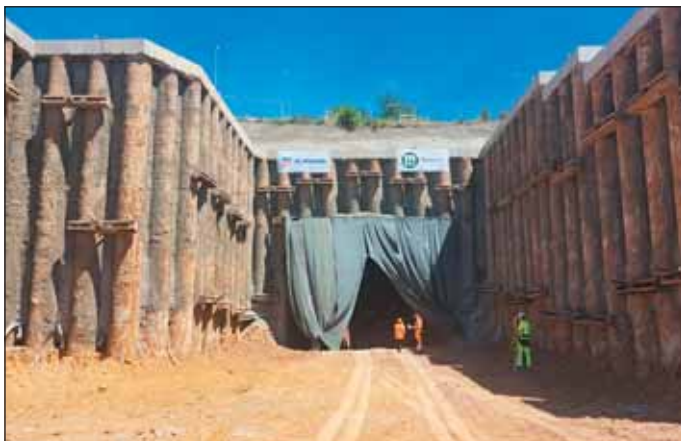
Obr. 5 Provizorní portál a stavební jáma hloubeného úseku Žebětín po dokončení ražeb Fig. 5 Temporary portal and construction pit for the cut-and-cover Zebětín section after completing excavation
