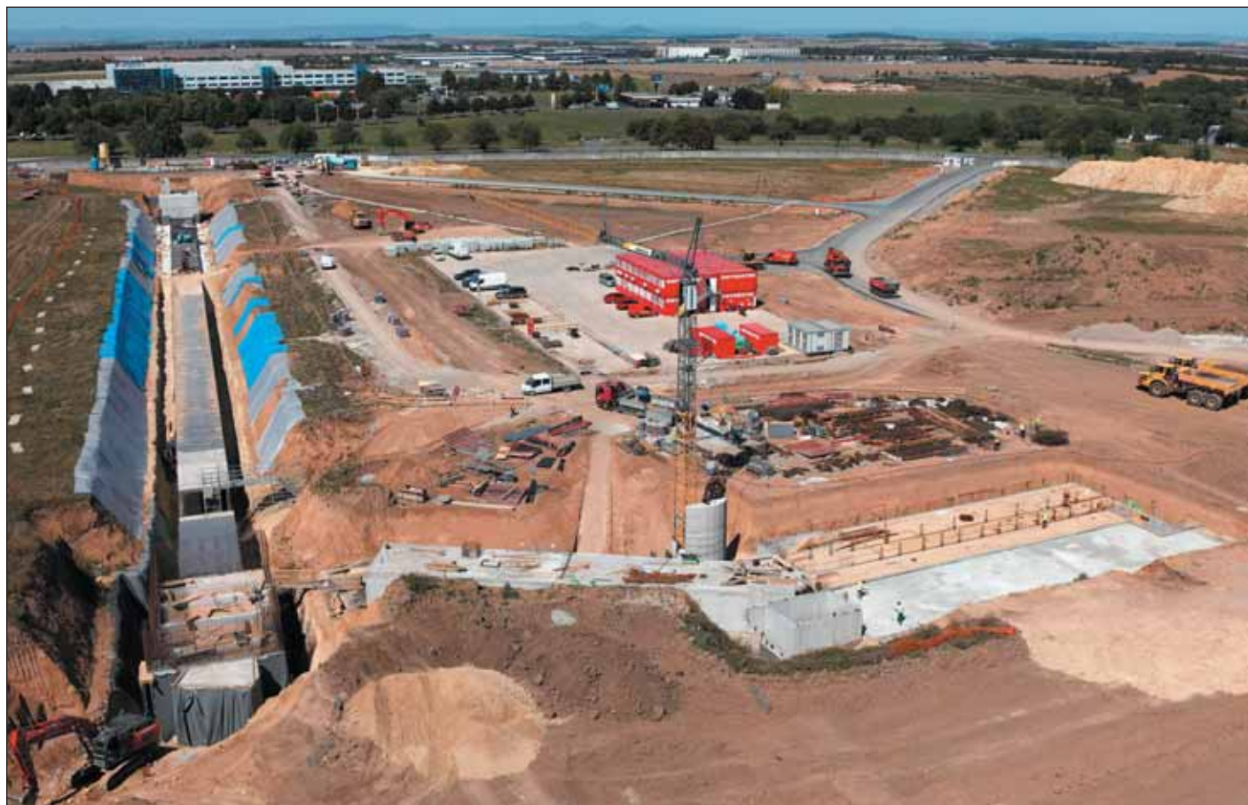
Obr. 1 Celkový pohled z dronu na výstavbu hloubené části kolektoru Fig. 1 Drone overview of the cut-and-cover utility tunnel section construction
