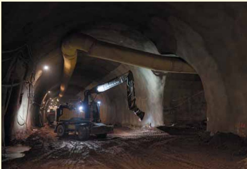
Obr. 9 Ústí propojky v levé tunelové trubě, tunel Opevnění
