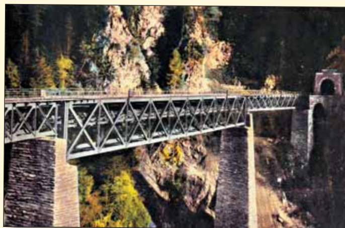
Obr. 7 Tauernbahn. Pfaffenberg-Zwenberg-Viadukt (Kärnten). [Taurská dráha. Viadukt Pfaffenberg-Zwenberg (Korutany).] Kolorovaná fotografie. Purger & Co., München. Photochrom II. No. 9667. Okolo 1920. [sbírka autorů] [7].
