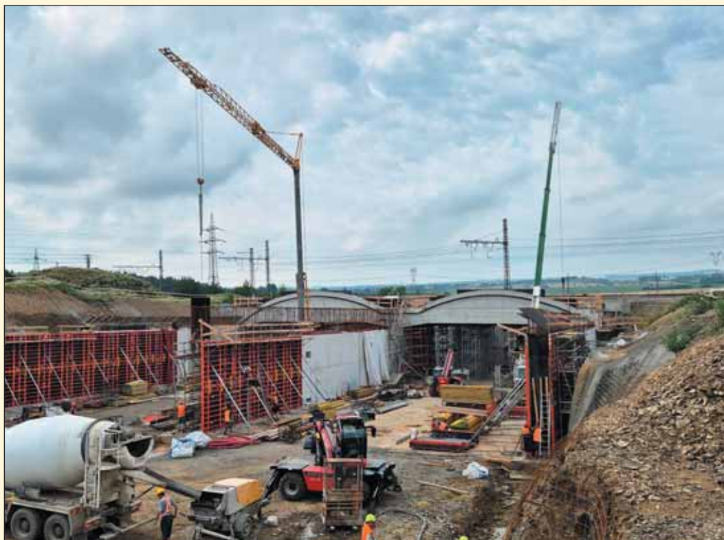
Obr. 12 Výstavba tunelu Na Vysoké – sekce pod dráhou Fig. 12 Na Vysoké tunnel construction – section underneath the railway
