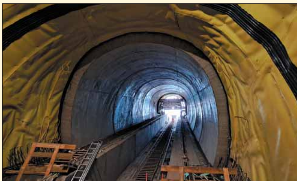
Obr. 4 Definitivní ostění eskalátorového tunelu stanice Olbrachtova
