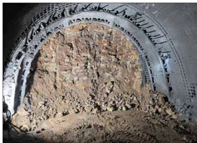
Obr. 4 Nezajištěná čelba kaloty z různě zvětralých slínovců při ražbě od šachty Š8 k TK7
