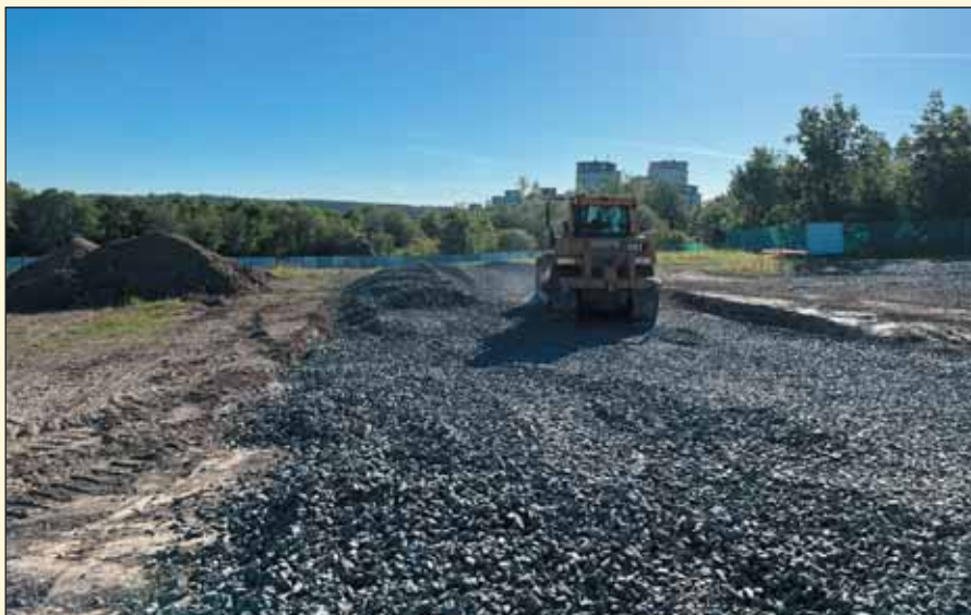
Obr. 3 Pohled na přípravu území staveniště Nové Dvory
