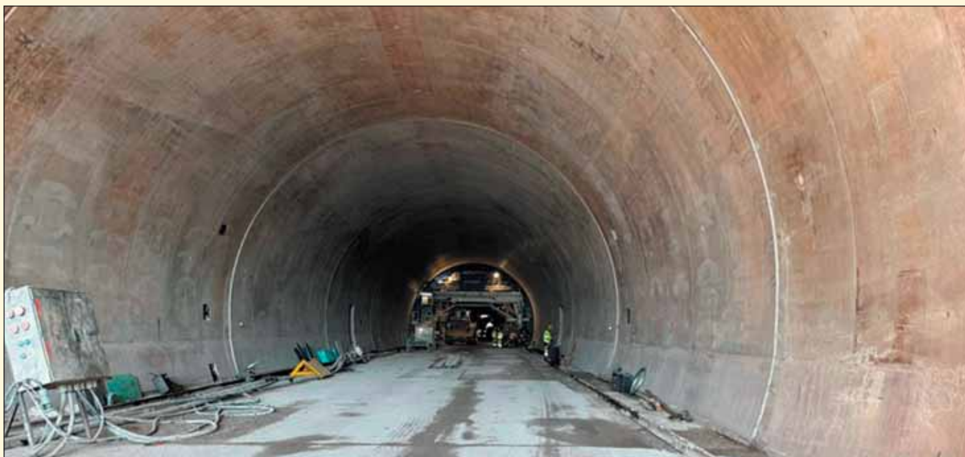
Obr. 14 Armovanie hornej klenby sekundárneho ostenia v tuneli Španí Háj
