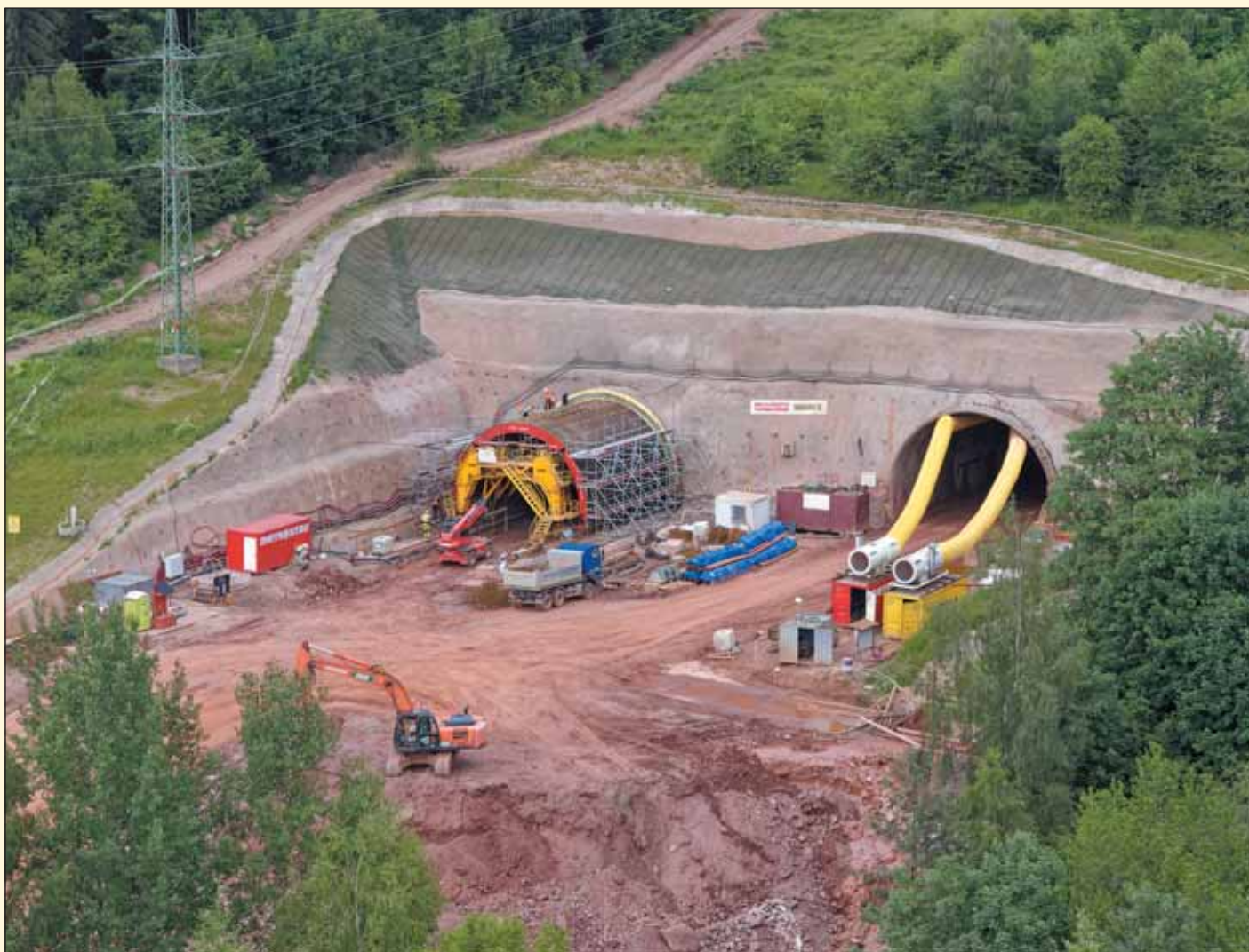
Obr. 8 Jižní portál tunelu Opevnění Fig. 8 Southern portal of the Opevnění tunnel
