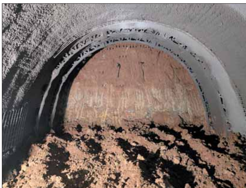
Obr. 4 Čelba kaloty tvořená jílovitými zeminami s písčitou příměsí (TM 264) Fig. 4 Top heading face formed by sandy clay (TM 264)
