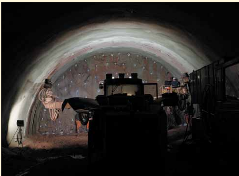
Obr. 10 Umístování rozbušek v levé tunelové trubě tunelu Opevnění
