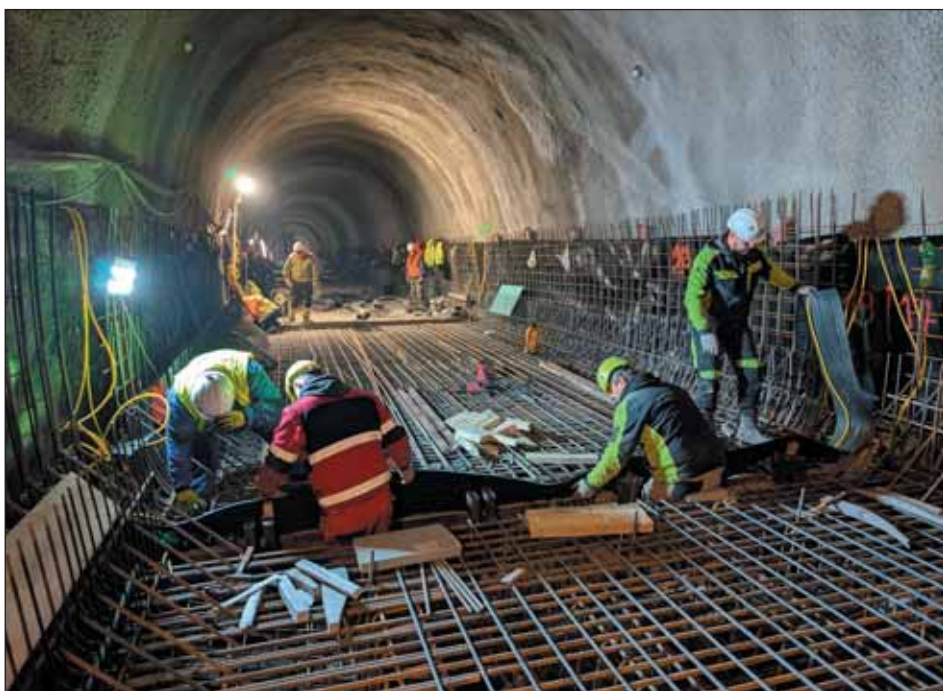
Obr. 11 Výztuž dna sekundárního ostění a instalace vnitřních těsnicích pásů
