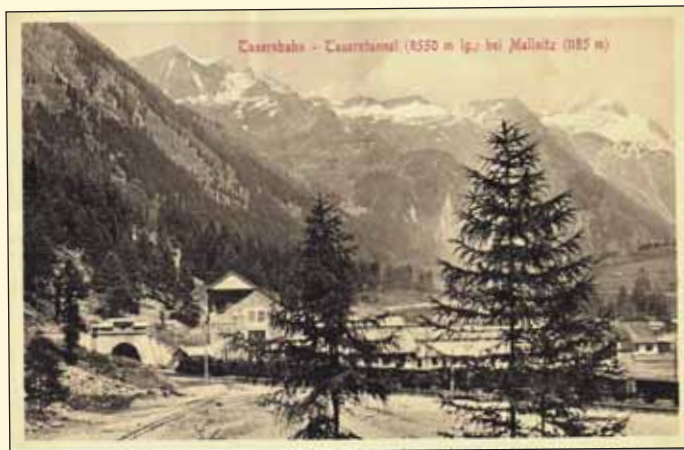
Obr. 3 Tauernbahn – Tauertunnel (8550 m lg.) bei Mallnitz (1185 m). [Taurská dráha – Taurský tunel (dlouhý 8550 m) u Mallnitz (1185 m n. m.).] Stengel & Co., G.m.b.H., Dresden. 1911 [sbírka autorů].
