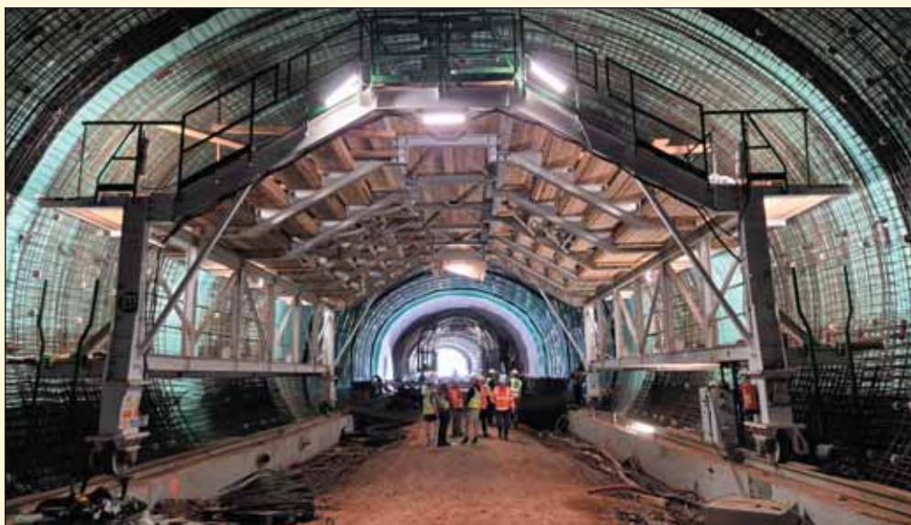
Obr. 6 Montážní plošina výztuže horní klenby, tunel Radechová Fig. 6 Assembly platform for upper vault rebar, the Radechová tunnel
