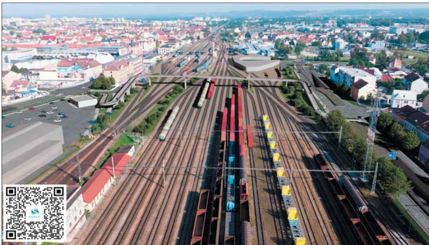
Obr. 10 Celkový pohled na dokončenou stavbu od jihu Fig. 10 An overview of the finished structure from the south
