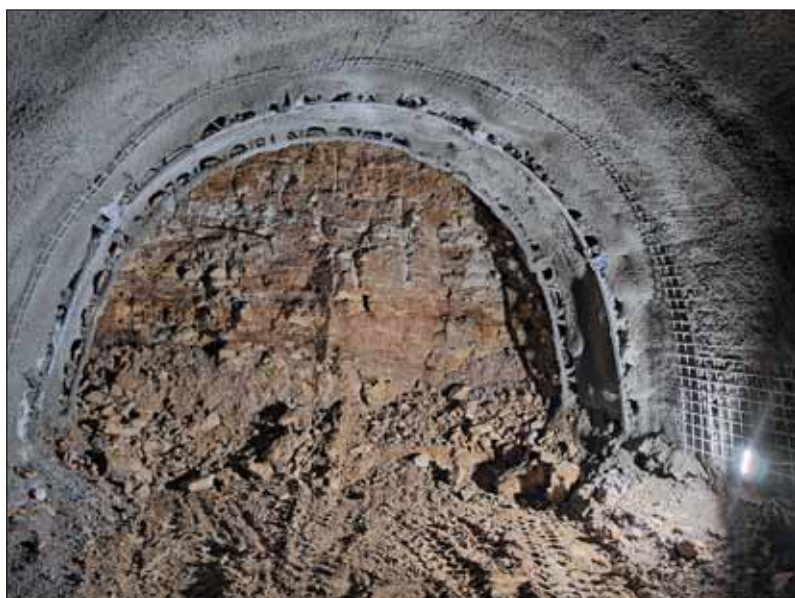
Obr. 3 Čelba kaloty tvořená písčitými slínovci s deskovitou odlučností (TM 66) Fig. 3 Top heading face formed by sandy marlstones with slab-like bedding (TM 66)
