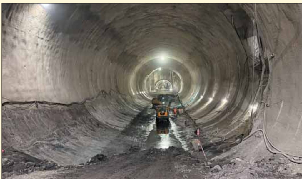
Obr. 5 Pohled do vyražené stanice Pankrác D
