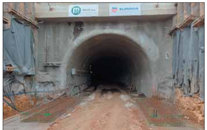
Obr. 4 Jižní portál Bystrc, montáž výztuže základových pásů hloubeného tunelu Fig. 4 Bystrc southern portal, assembly of rebar for strip footing of the cut-and-cover tunnel
