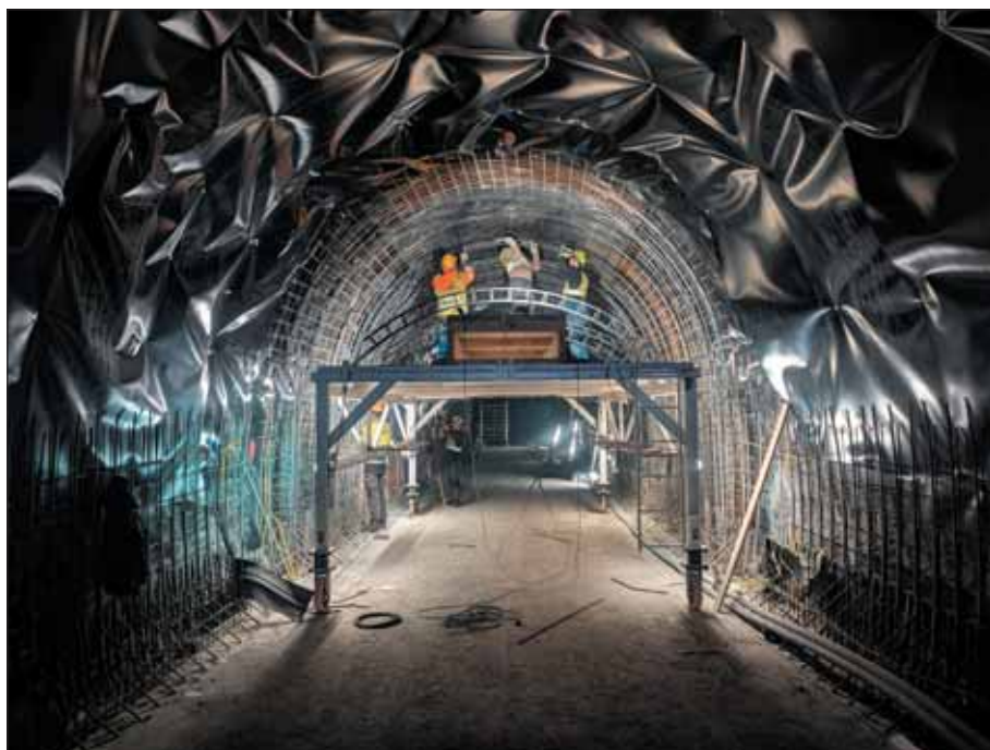
Obr. 12 Separáčnı́ fólie a montáž vřztuže hornı́ klenby z pojřzdné plořiny
