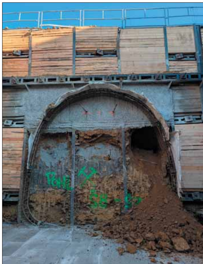
Obr. 9 Prorážka do šachty TK7
