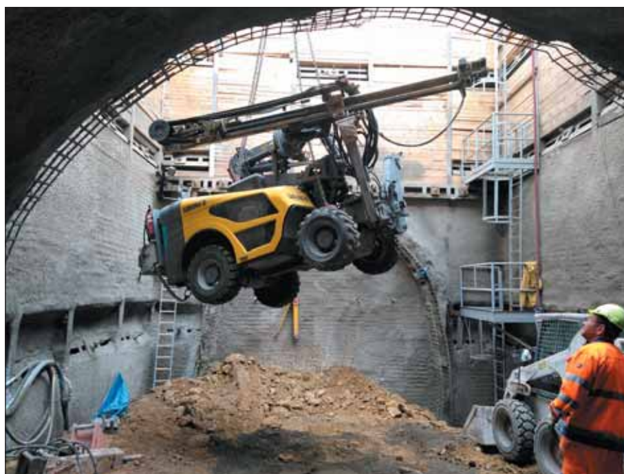
Obr. 6 Rozrážka ze šachty Š08
