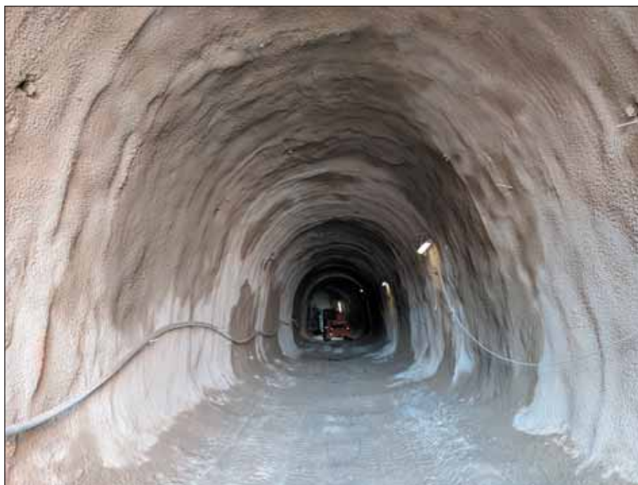
Obr. 10 Primární ostění po profilaci
