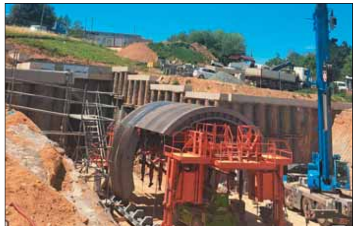
Obr. 6 Montáž formy pro betonáž sekundárního ostění Fig. 6 Assembly of formwork for the concreting of secondary lining
