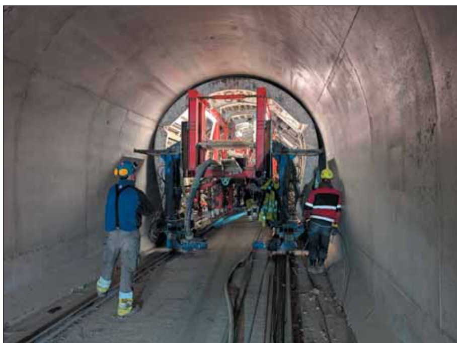
Obr. 13 Bednicı́ vřz sekundárního ořtění
