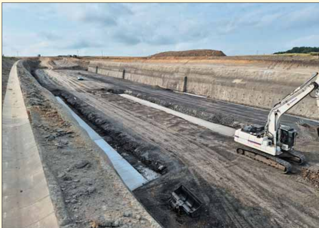
Obr. 11 Stavební jáma tunelu Dubeč Fig. 11 Dubeč tunnel construction pit
