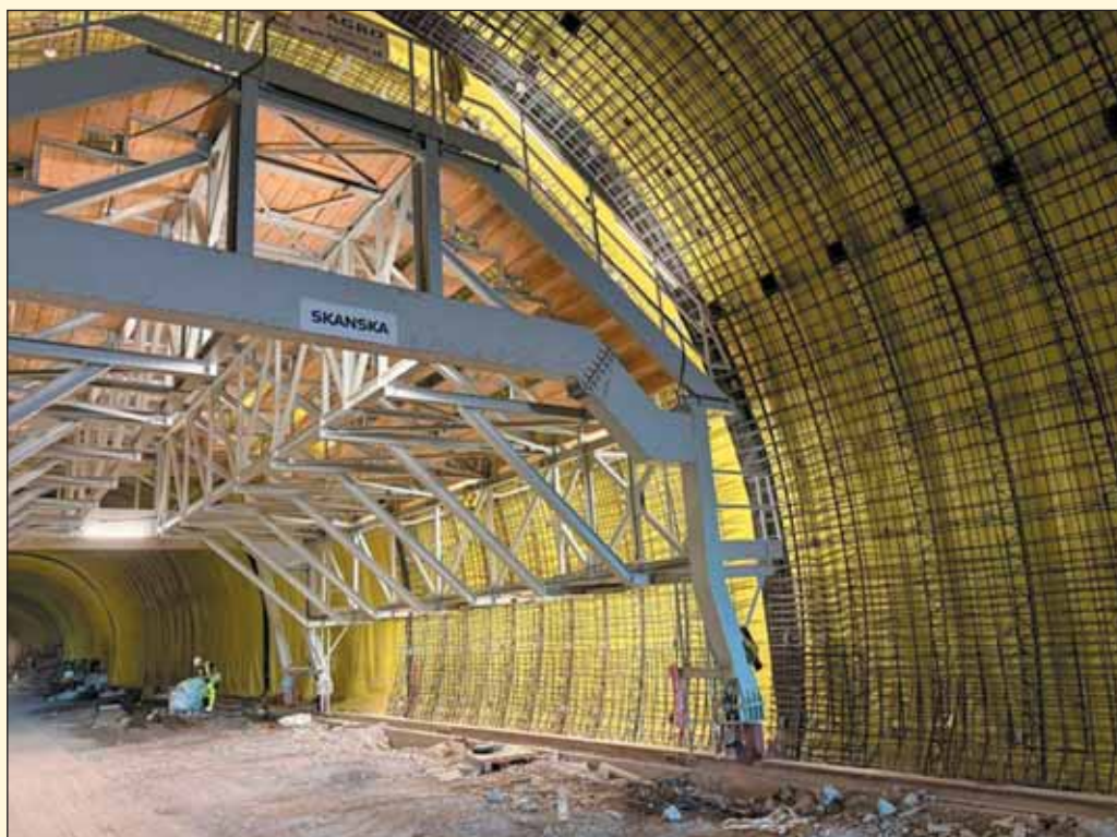
Obr. 13 Klenba hĺbeného úseku tunela Španí Háj
