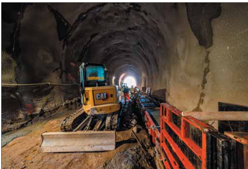
Obr. 8 Základové pásy sekundárního ostění Fig. 8 Strip foundations of the secondary lining
