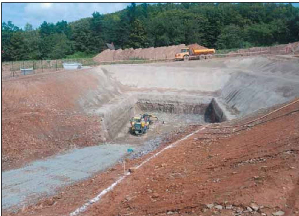
Obr. 4 Zajištění stěn portálové jámy stříkaným betonem Fig. 4 Securing of portal pit walls with sprayed concrete
