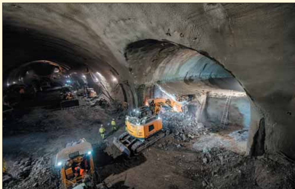
Obr. 2 Pohled z čela stanice Pankrác na ražbu přestupní chodby Fig. 2 View from the face of the Pankrác station at the excavation of the transfer corridor
