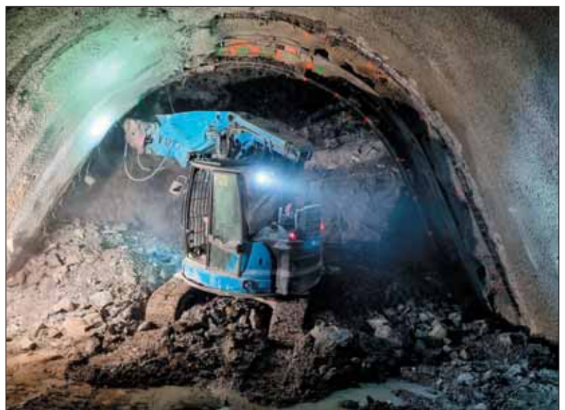
Obr. 4 Ražba patní štoly Fig. 4 Excavation of the base gallery
