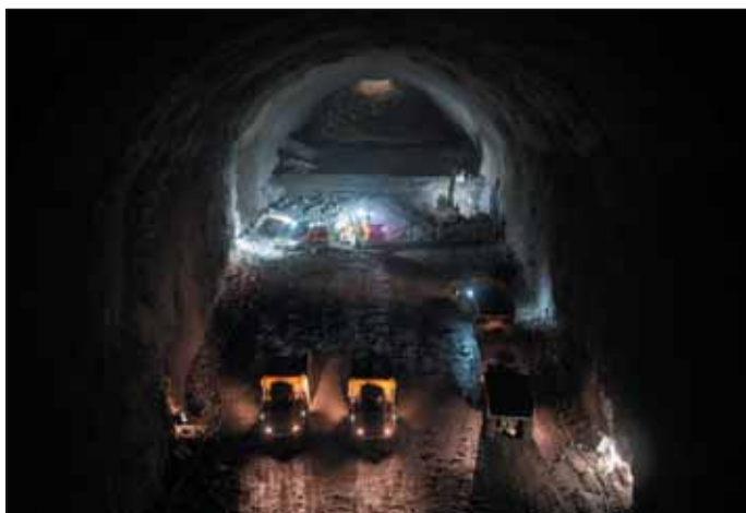
Obr. 3 Odtěžba, kaverna 23 Fig. 3 Extraction, cavern 23
