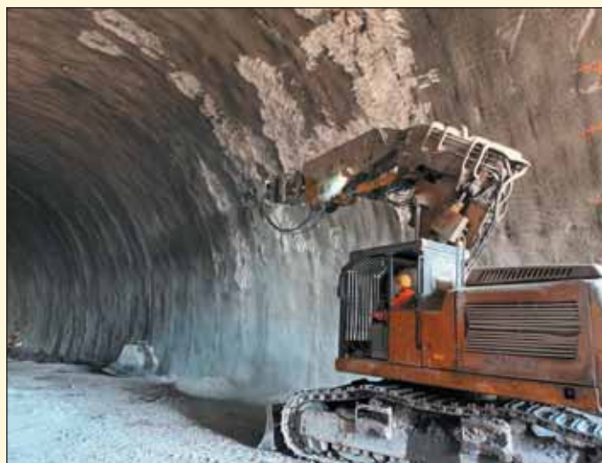
Obr. 16 Reprofilácia primárneho ostenia v tuneli Španí Háj Fig. 16 Reprofiting of the primary lining in the Španí Háj tunnel
