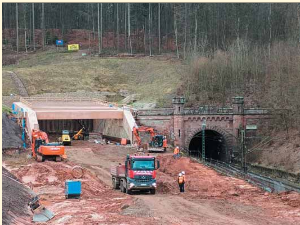
Obr. 1 Pohled na zajišťování východního portálu tunelu Cornberg, vpravo původní historický tunel Fig. 1 View of eastern Cornberg tunnel portal securing, on the right, the original historic tunnel
