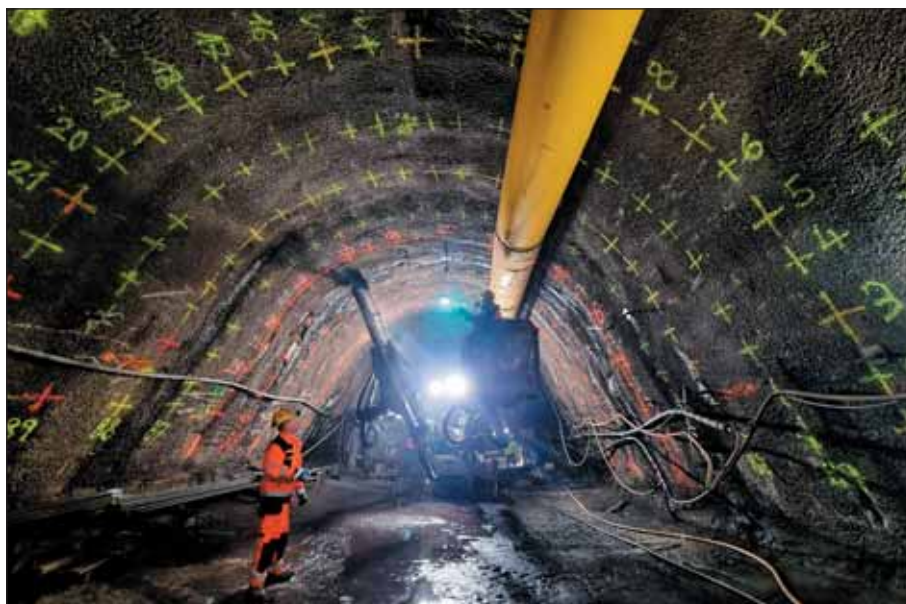
Obr. 5 Injektáže horninového prostředí budoucí ražby stanice z patní štoly Fig. 5 Grouting of the rock massif from the base gallery for future station excavation
