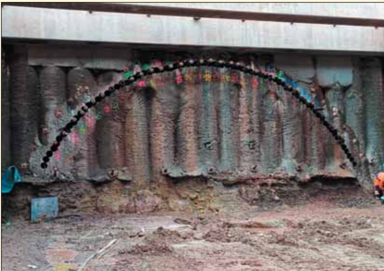
Obr. 2 Zajištění východního portálu tunelu Cornberg pro zahájení ražeb Fig. 2 Securing the eastern portal of the Cornberg tunnel to commence excavations
