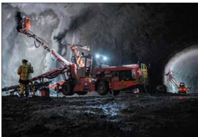
Obr. 5 Zajišťování stěn úrovně 2, kaverna 23 Fig. 5 Securing of level 2 walls, cavern 23
