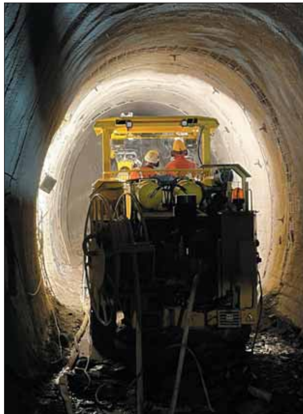
Obr. 7 Epiroc Boomer 282 vrtá čelbu pro odpal dalšího záběru Fig. 7 Epiroc Boomer 282 drilling the face for blasting of the following advance
