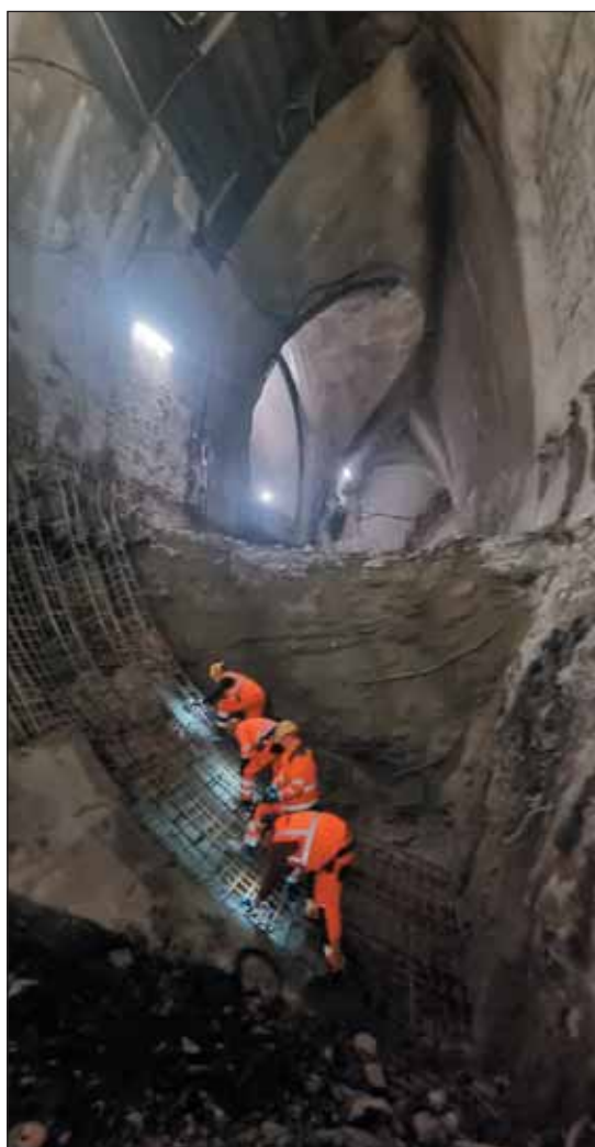
Obr. 8 Ražba opěří II a dna Fig. 8 Bench II and invert excavation
