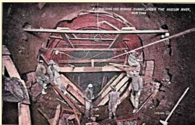
Obr. 3 Stavba tunelu McAdoo pod řekou Hudson v New Yorku. The Valentine & Sons' Publishing Co., Ltd., New York. 1911 [sbírka autorů].
