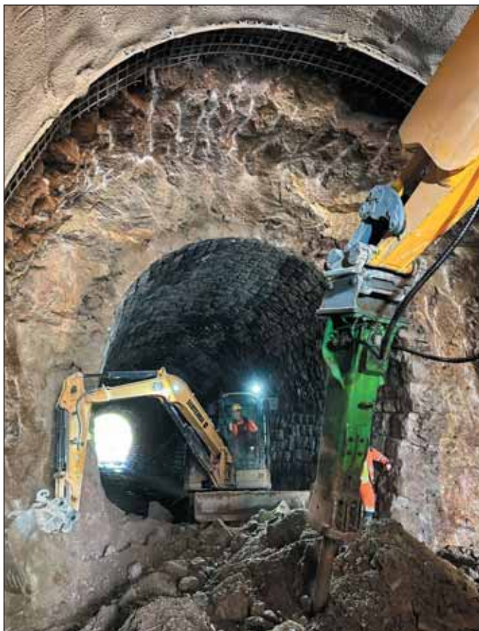
Obr. 2 Práce na zvětšování výrubu tunelu Fig. 2 Work on the enlargement of the tunnel excavation
