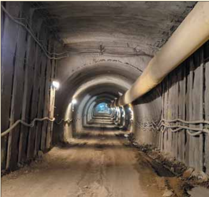
Obr. 5 Přechod z profilu P1 na profil P4 Fig. 5 Transition from P1 to P4 profile
