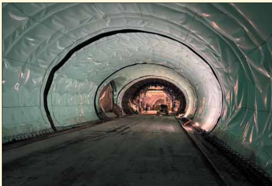
Obr. 3 Pohled na provedenou izolaci dvoukolejného tratového tunelu Fig. 3 View of the finished waterproofing of the twin-track tunnel
