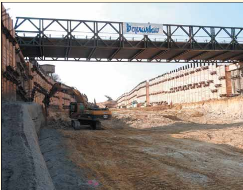
Obr. 11 Pohled západním směrem na stavební jámu s mostním provizoriem k zámku Stránov Fig. 11 Western view of the construction pit with a makeshift bridge towards the Stránov Château
