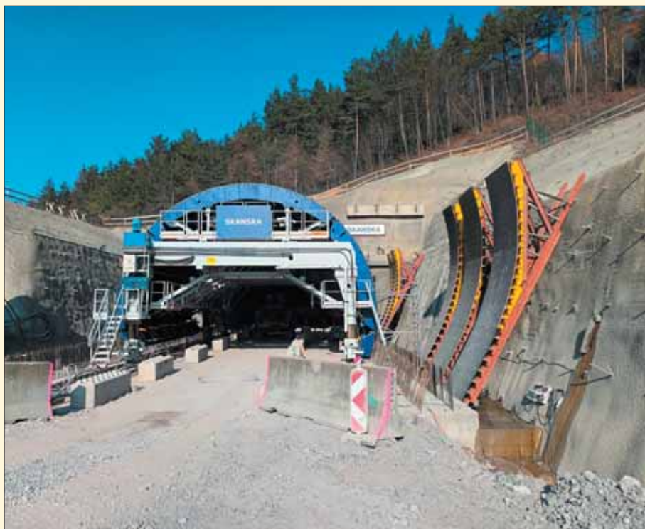
Obr. 17 Debniaci voz pripravený na montáž výstuže na východnom portáli tunela Španí Háj Fig. 17 Formwork carriage prepared for reinforcement assembly at the eastern portal of the Španí Háj tunnel
