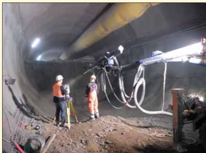
Obr. 3 Zajištění vyraženého úseku opeří a dna tunelu Holstein Fig. 3 Securing in a section of the excavated bench and invert of the Holstein tunnel
