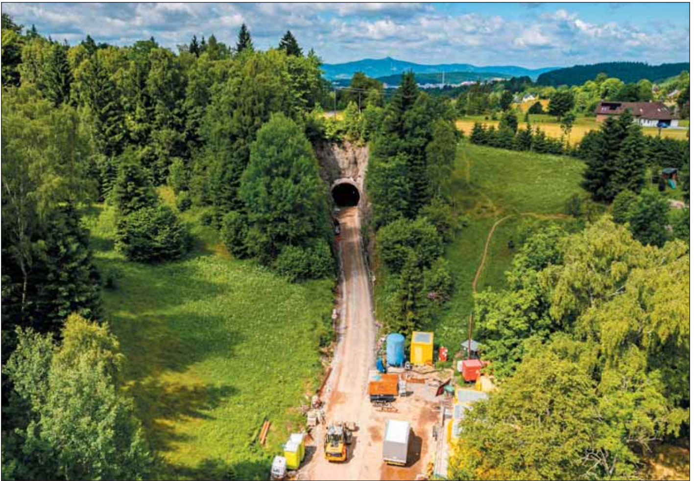
Obr. 12 Omezený prostor zařízení staveniště
