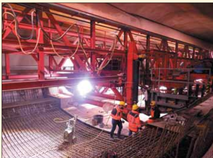
Obr. 2 Betonáž spodní klenby ZTT tunelu Holstein Fig. 2 Concreting the WTT lower invert of the Holstein tunnel
