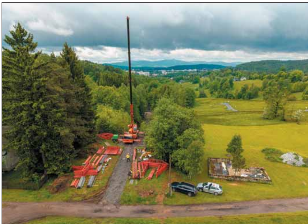
Obr. 6 Předmontáž segmentů tunelové formy Fig. 6 Pre-assembly of tunnel form segments
