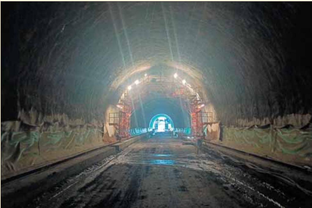
Obr. 15 Príprava na betonáž hornej klenby sekundárneho ostenia v tuneli Okruhliak Fig. 15 Preparation for concreting the upper vault of the secondary lining in the Okruhliak tunnel
