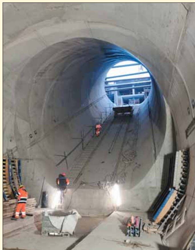
Obr. 4 Pohled na provedené definitivní ostění eskalátorového tunelu Fig. 4 View of the finished final lining of the escalator tunnel
