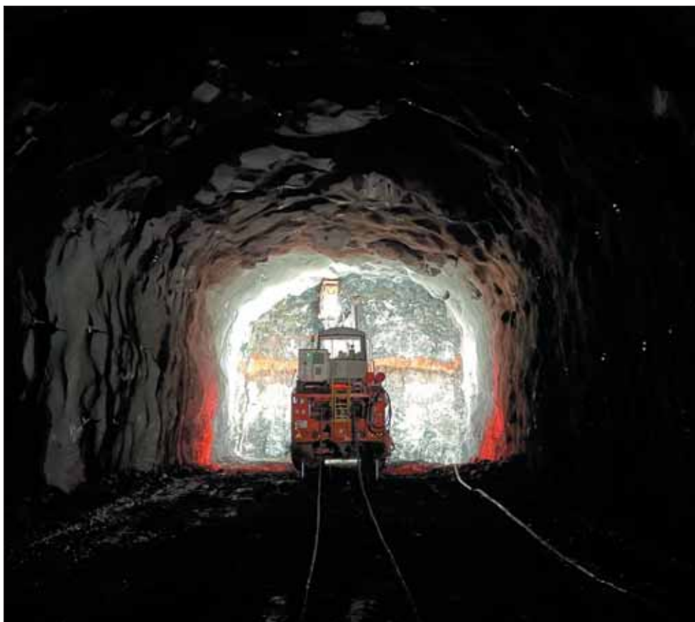
Obr. 4 Vrtný vůz Sandvik DT 1131i na čelbě
