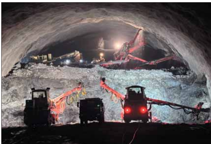
Obr. 9 Razenie lavice č. 2, zaistenie lavice č. 1 a č. 2 súbežne Fig. 9 Excavation of bench no. 2, simultaneous support installation on benches no. 1 and 2
