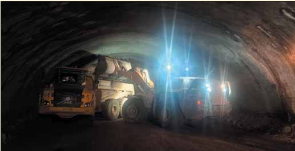
Obr. 9 Odtěžba rubaniny Fig. 9 Muck extraction
