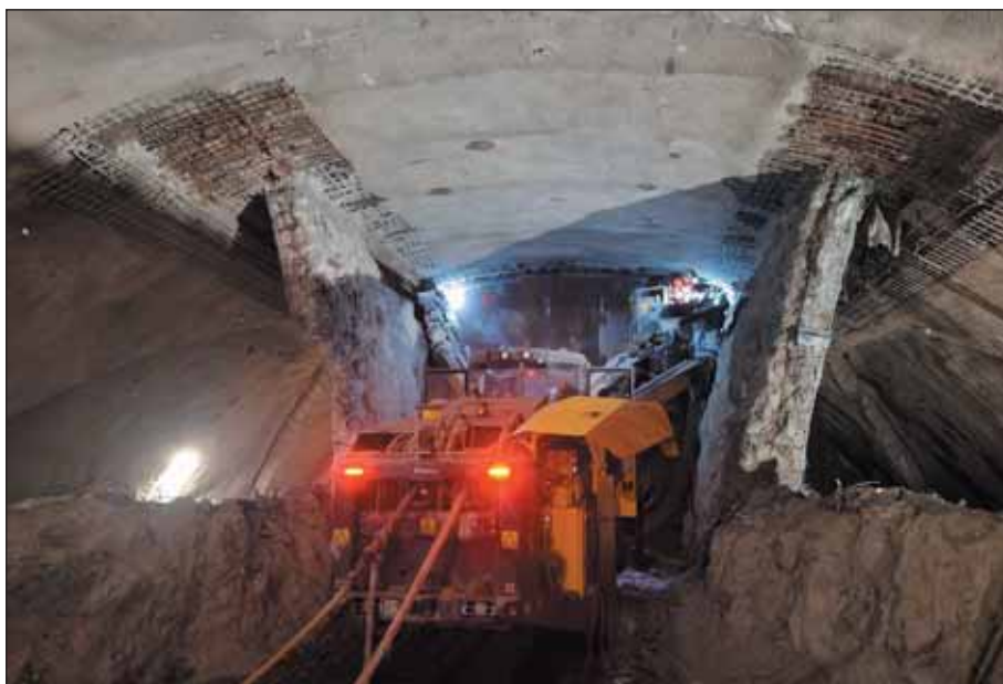
Obr. 9 Ražba kaloty středního dílčího výrubu Fig. 9 Central sequence top heading excavation
