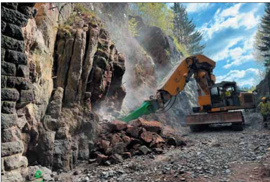
Obr. 1 Průběh odtěžování zvětralé horniny ve skalním svahu Fig. 1 Progress of weathered rock excavation in the rock slope
