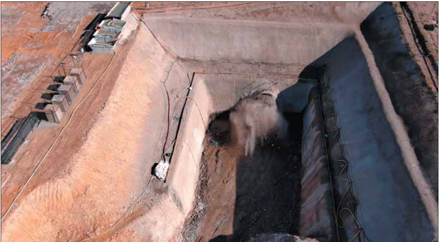
Obr. 9 Jeden z prvních odpalů po zahájení ražby
