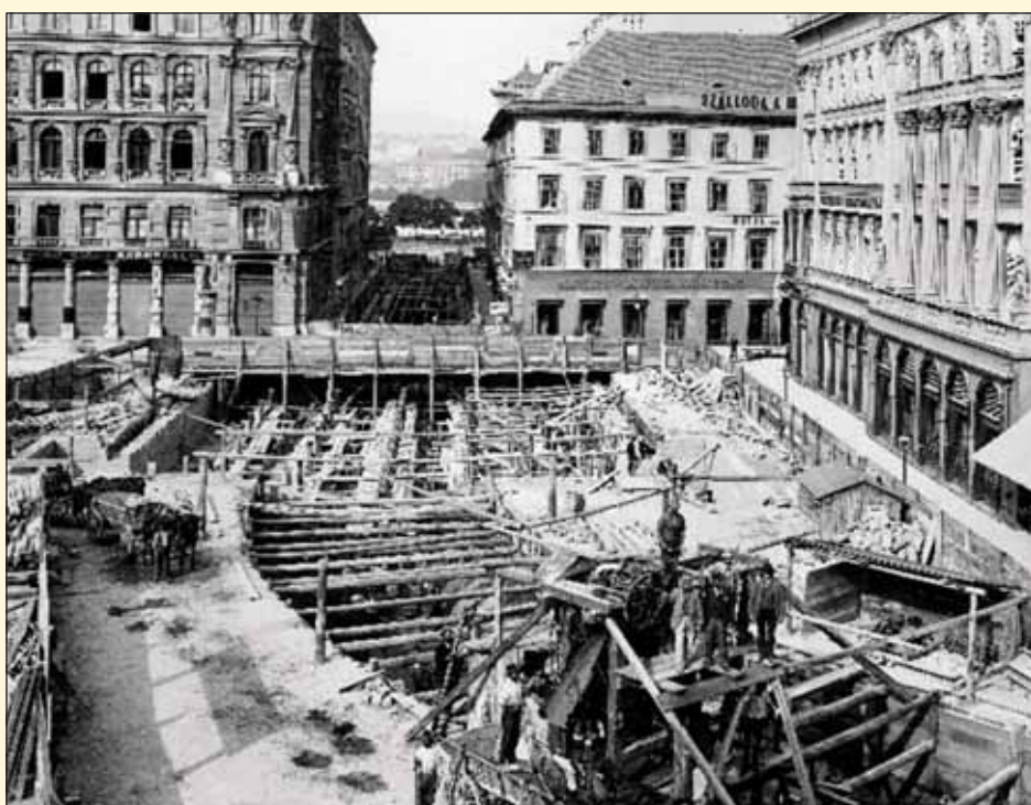
Obr. 3 Stavební jáma na náměstí Vörösmarty Fig. 3 Construction pit at the Vörösmarty Square
