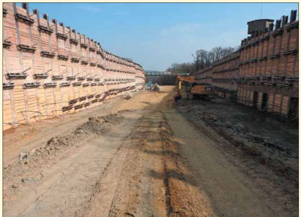
Obr. 10 Pohled do stavební jámy od východu (stav k 10. 3. 2026) Fig. 10 View into the construction pit from the east (status quo 10/03/2026)
