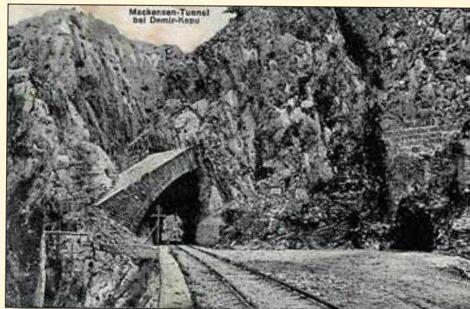
Obr. 10 Mackensenův tunel u Demir-Kapu. ? 1918 [sbírka autorů].
