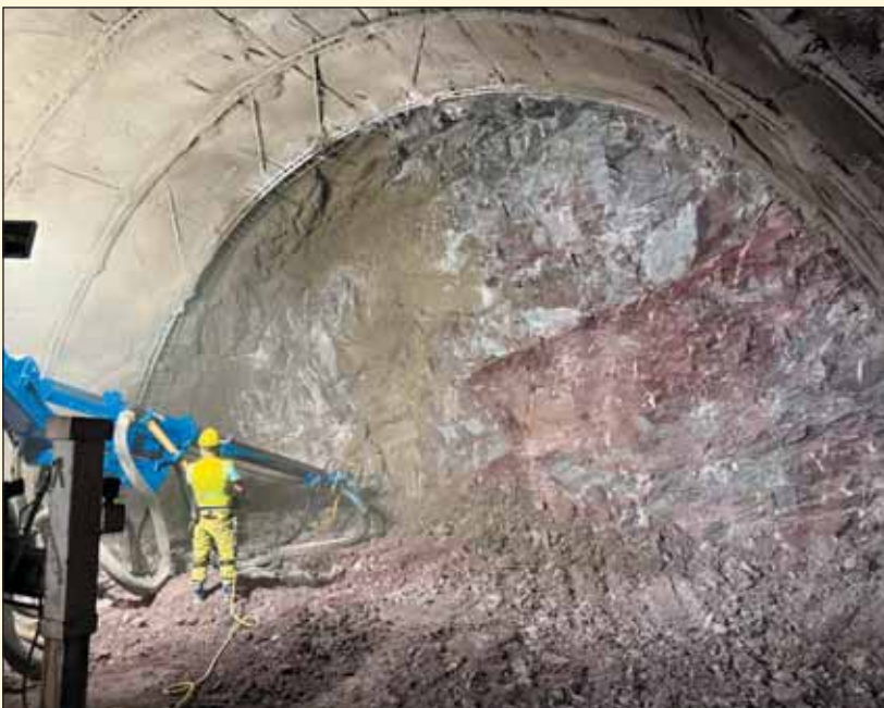
Obr. 10 Práce v čelbe tunela Španí Háj – aplikácia striekaného betónu
