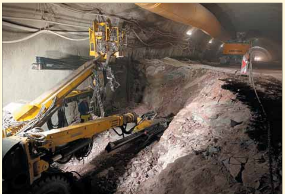
Obr. 11 Vrtacie práce v stupni tunela Španí Háj
