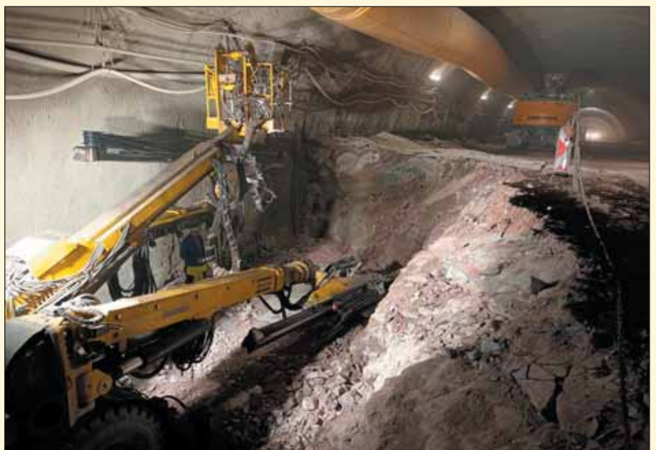
Obr. 11 Vrtacie práce v stupni tunela Španí Háj
