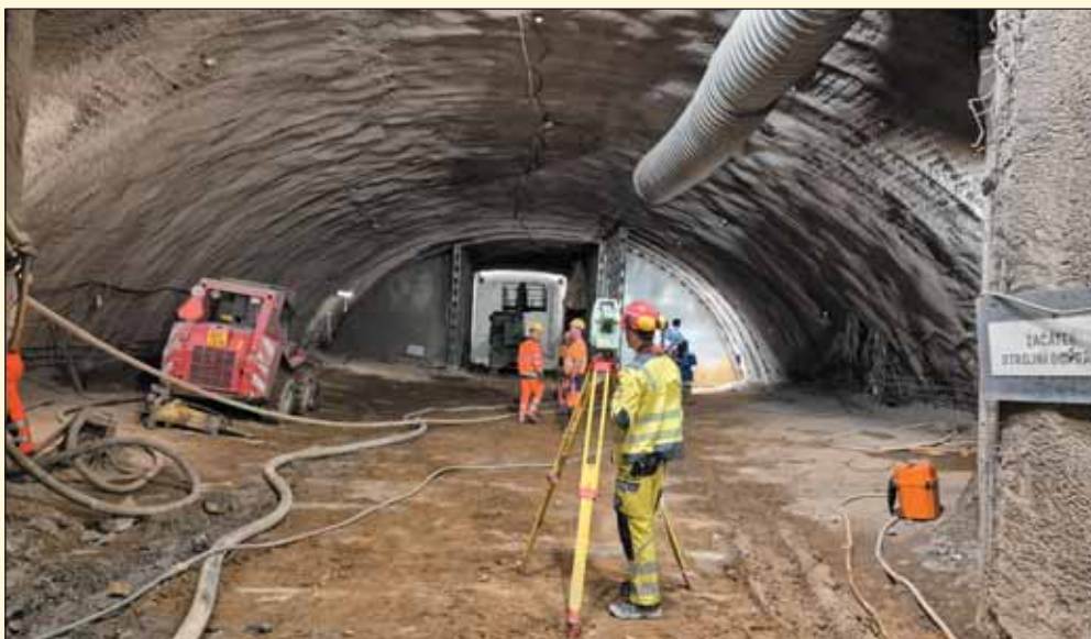
Obr. 9 Rozšíření průzkumné štoly na profil kaloty budoucího tunelu Fig. 9 Exploratory gallery enlargement into the top heading profile of the future tunnel
