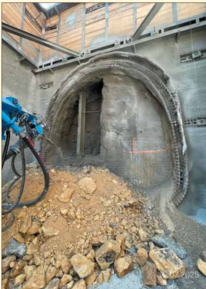
Obr. 7 Pohled na zahájení ražeb ze šachty Š9 z července 2025 Fig. 7 A view at the commencement of excavations from the Š9 shaft from July 2025
