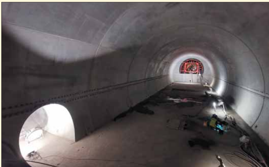
Obr. 3 Pohled na část technologického tunelu v provedení definitivní obzdvíčky Fig. 3 A view of a part of the technological tunnel with complete definitive lining
