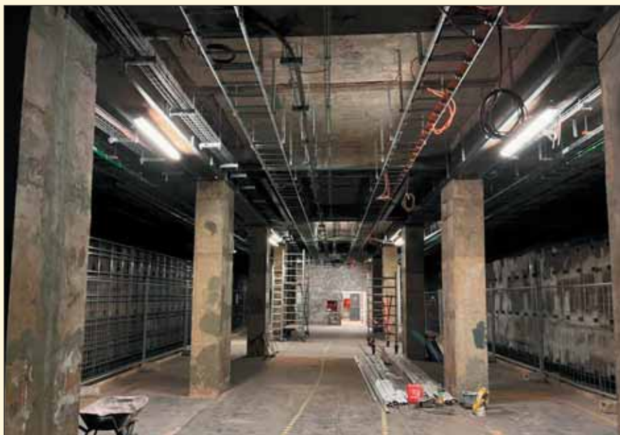
Obr. 1 Modernizace stanice Pankrác C Fig. 1 Modernisation of the Pankrác C station
