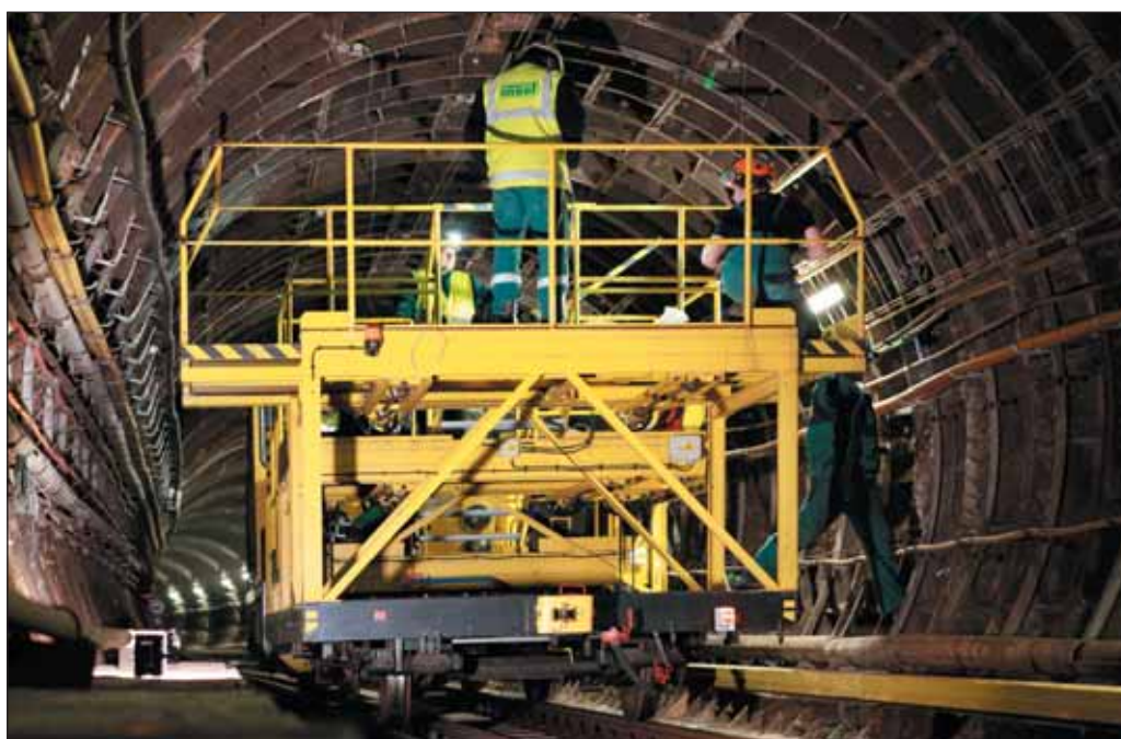
Obr. 2 Instalace náklonoměrných snímačů v ražené části traťového tunelu metra C Fig. 2 Installation of inclinometer sensors in the excavated part of the Metro C track tunnel
