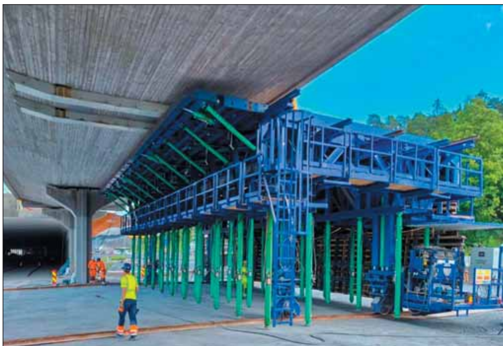
Obr. 8 Průjezd bednicího zařízení pod mostem – příčný přesun zařízení – v pozadí tunel Høvik v rámci projektu modernizace silnice E18 v norském Oslu
