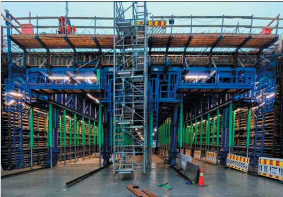
Obr. 7 Zařízení při betonáži ve výšce 8 metrů – tunel Høvik v rámci projektu modernizace silnice E18 v norském Oslu
