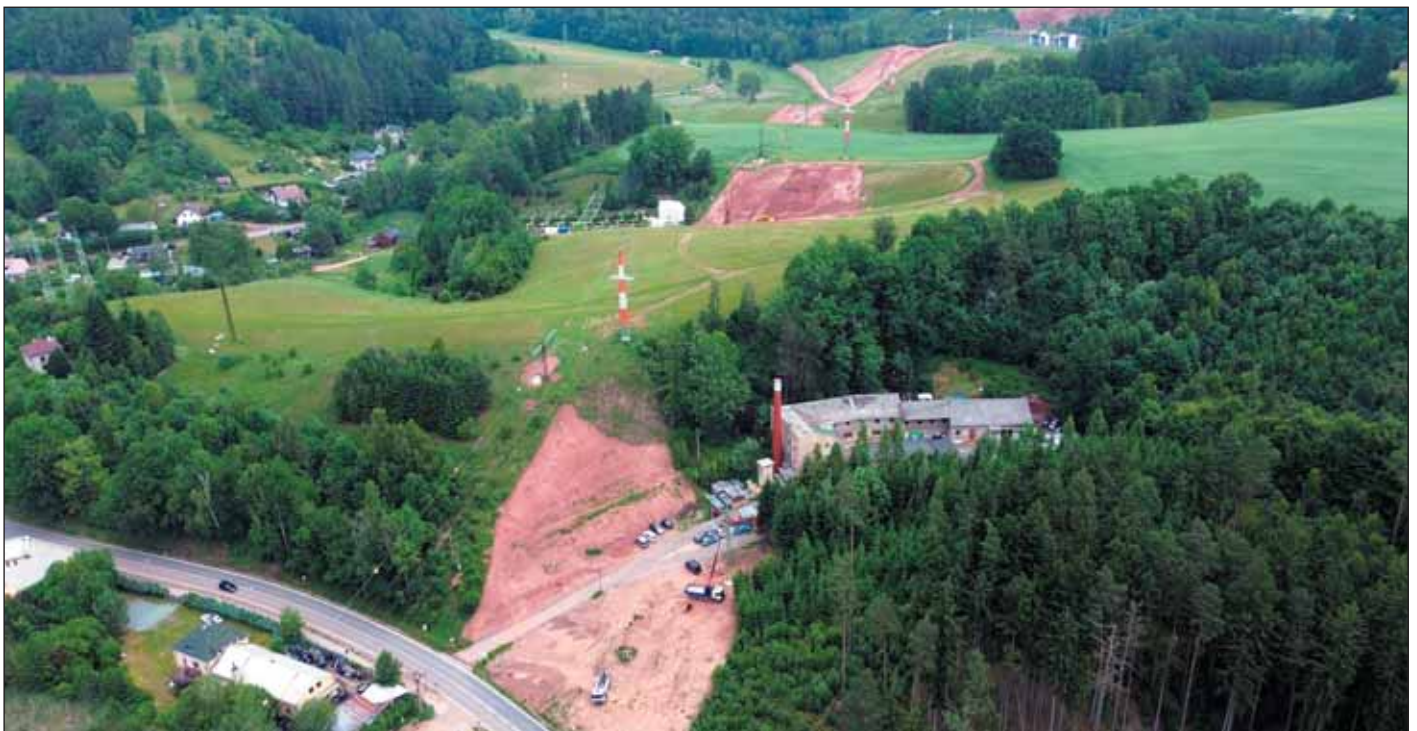
Obr. 8 Pohľad na trasu tunela (v popredí portál Dolní Radechová, následne stredný úsek v blízkosti cintorína)
