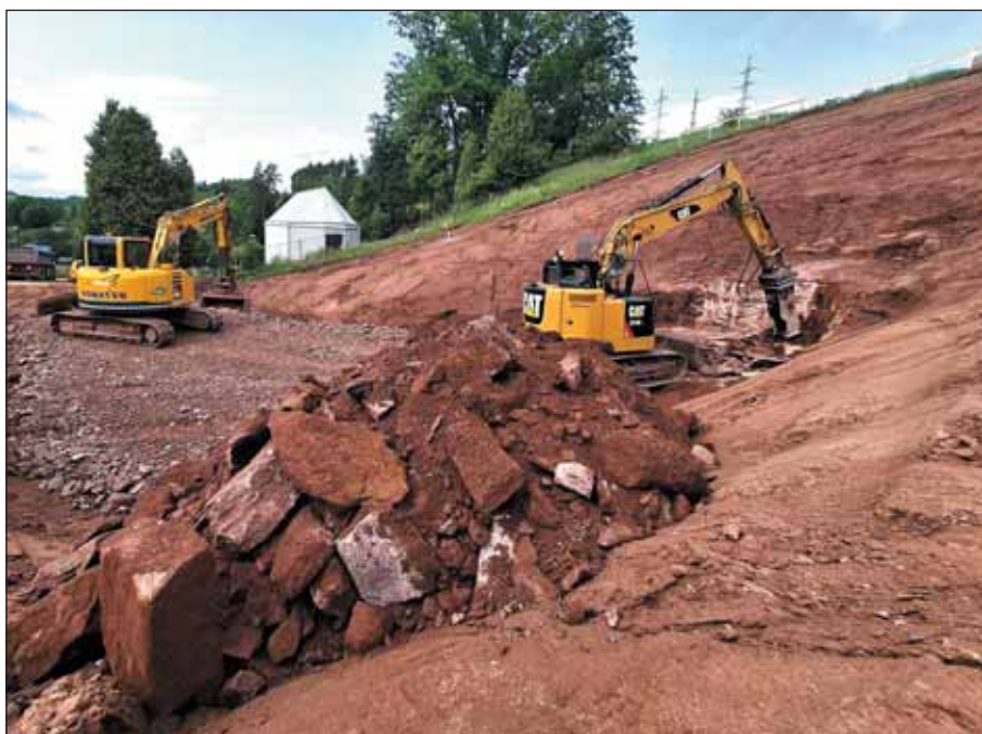
Obr. 3 Výkopové práce v oblasti strednej jamy – priamy prechod kvartérneho pokryvu na skalné podložie Fig. 3 Excavation works in the central trench area – direct transition from Quaternary cover to bedrock
