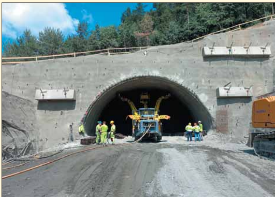
Obr. 13 Východný portál tunela Španí háj – vrtanie druhého mikropilótového dáždnika Fig. 13 Eastern portal of the Španí Háj Tunnel – drilling of the second micro-pile umbrella
