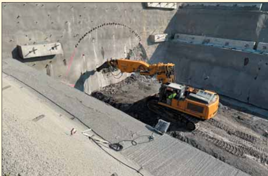
Obr. 14 Otváranie prvej čelby pod ochranou mikropilótového dáždnika Fig. 14 Opening of the first tunnel face under the protection of the micro-pile umbrella
