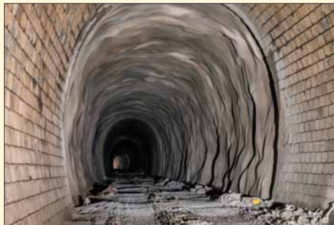
Obr. 9 Podkladní vrstva stříkaného betonu pro aplikaci stříkané EVO izolační membrány na skalním líci
