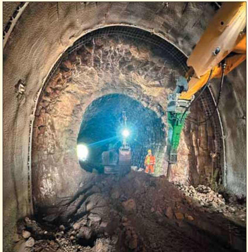
Obr. 5 Ražba rozšířeného profilu tunelu od výjezdového portálu Fig. 5 Excavation of the enlarged profile of the tunnel from the exit portal
