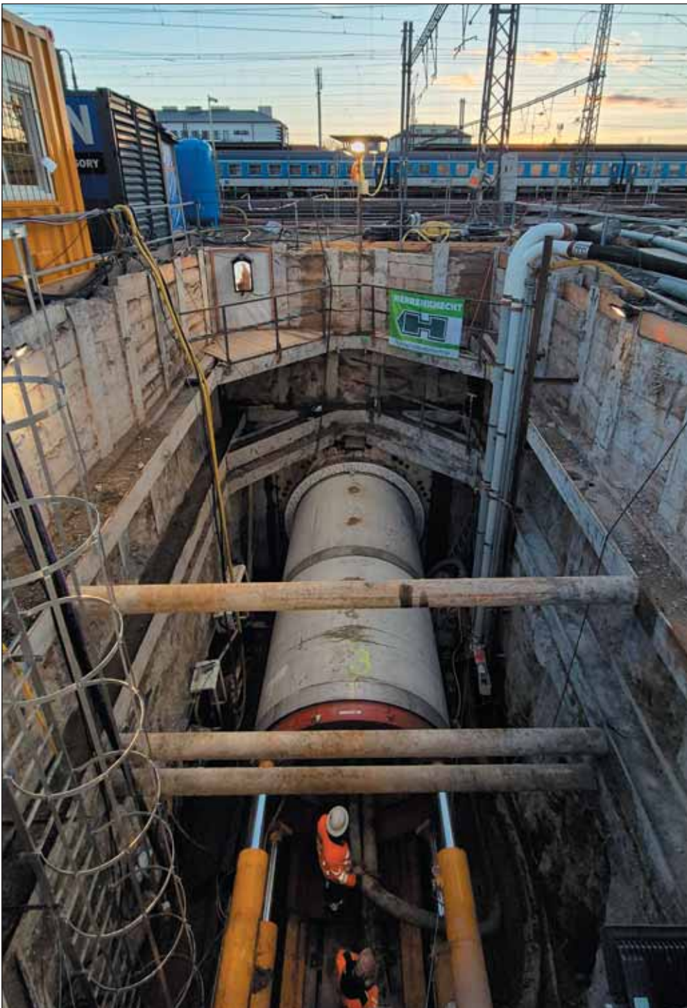
Obr. 5 Ražba kabelovodu při minimálním ovlivnění dopravy Fig. 5 Utility tunnel excavation with minimal impact on operations
