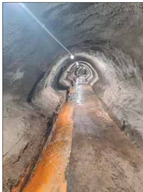
Obr. 4 Původní odvodňovací štola XXI. Fig. 4 Original XXI. drainage gallery
