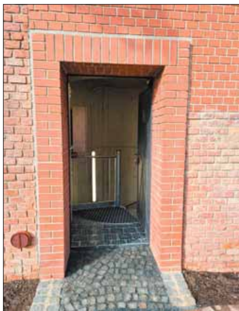
Obr. 10 Nově vybudovaný vstup v opěrné zdi za restaurací Nebozízek
