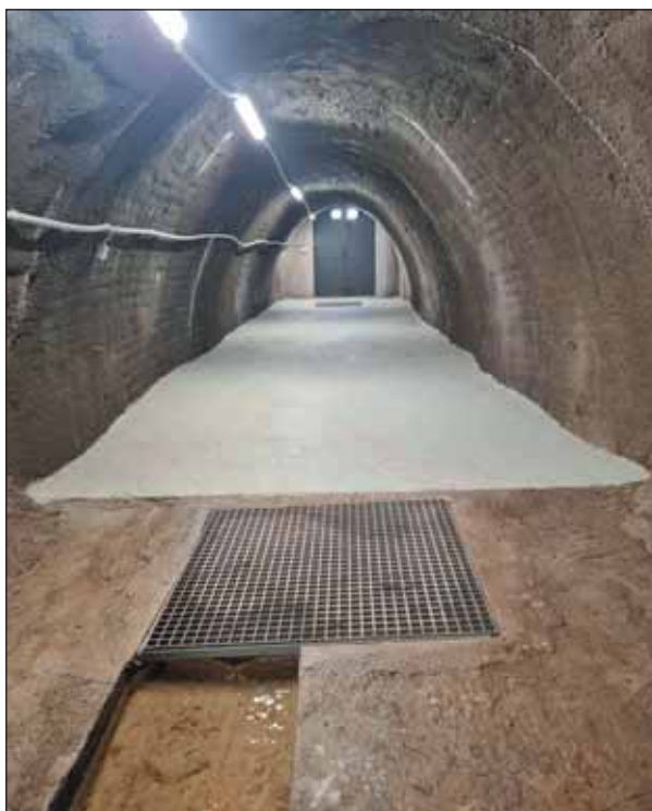
Obr. 8 Nově vybudovaná část štolu XXI. s dveřmi do portálu Fig. 8 Newly constructed section of the XXI. gallery with doors into the portal
