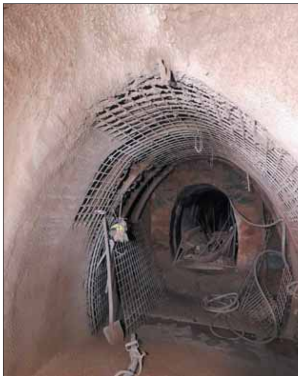
Obr. 1 Starý a nový profil odvodňovací štoly X.
