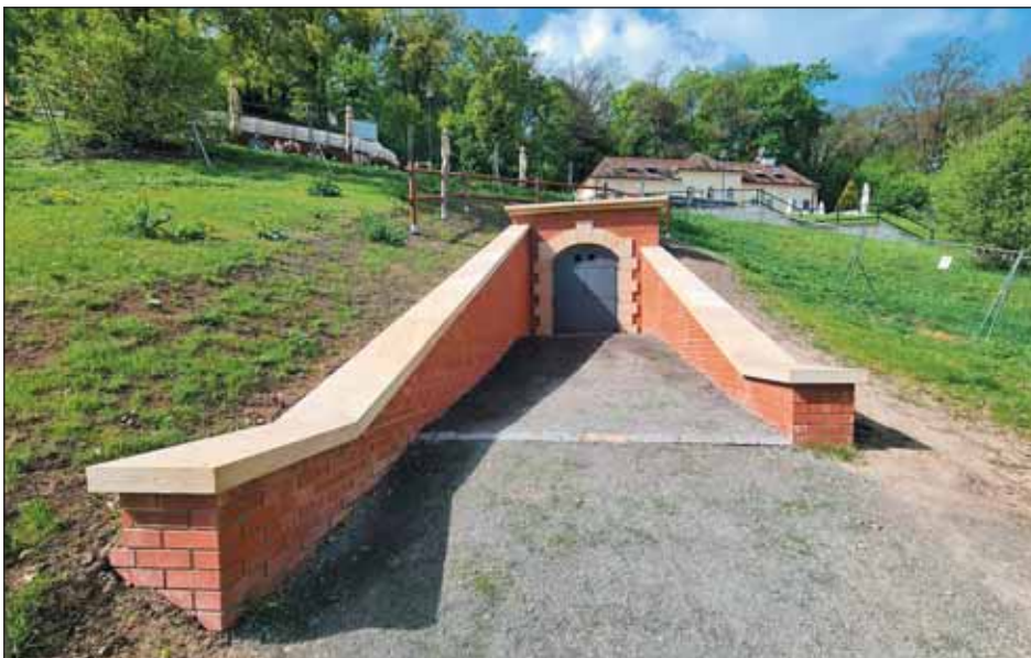
Obr. 6 Nový vstupní portál do štoly XXI. Fig. 6 New entrance portal into the XXI. gallery
