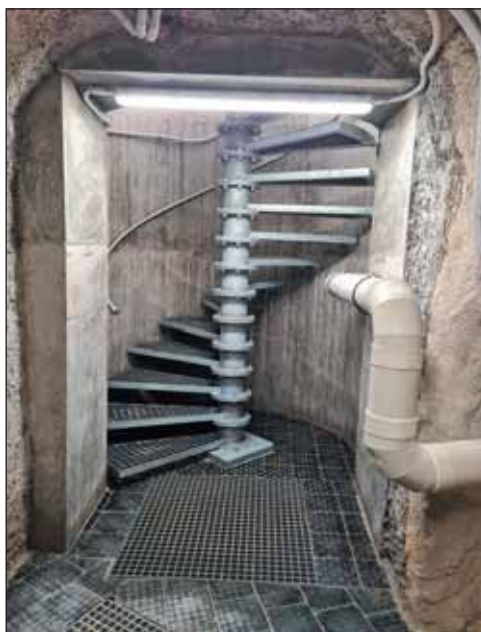
Obr. 11 Nové přístupové schodiště do štolý X.
