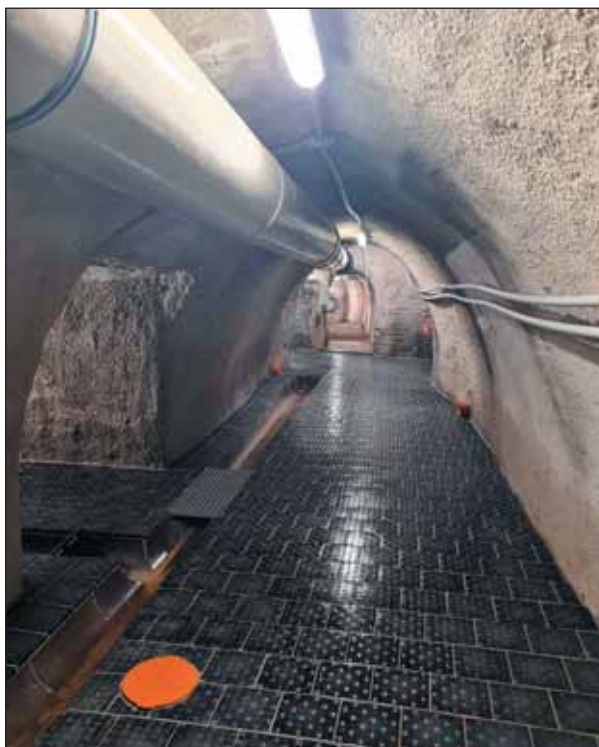
Obr. 9 Nově vybudovaná odvodňovací štolu X. Fig. 9 Newly constructed X. drainage gallery
