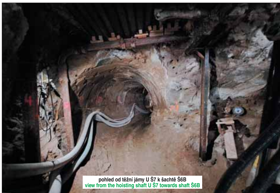
Obr. 3 Stará štola se směrovými lomy Fig. 3 Old tunnel with change in horizontal alignment
