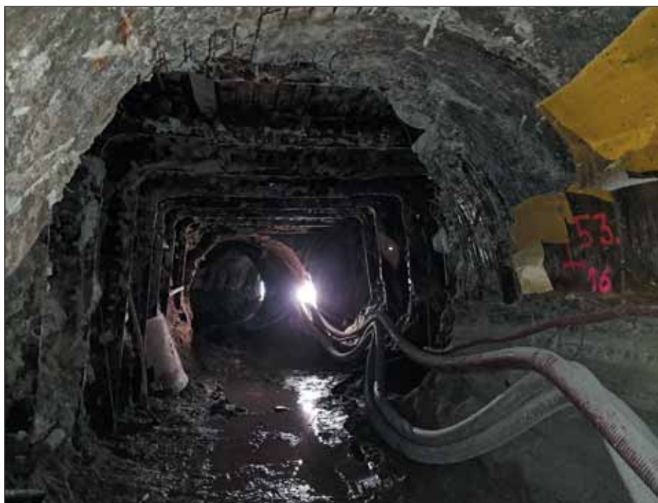
Obr. 2 Původní štola s rámy LB (lichoběžníkový průřez se sklonem bočních stran 1 : 6) Fig. 2 Original tunnel with LB frames (trapezoidal cross-section with side slopes of 1 : 6)
