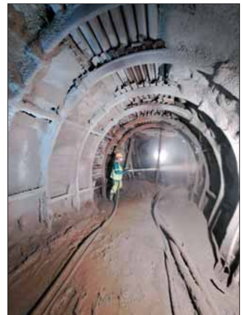
Obr. 7 Zajištění ocelové důlní výztuže Huta Łabedy S.A. – realizace střikaného betonu
