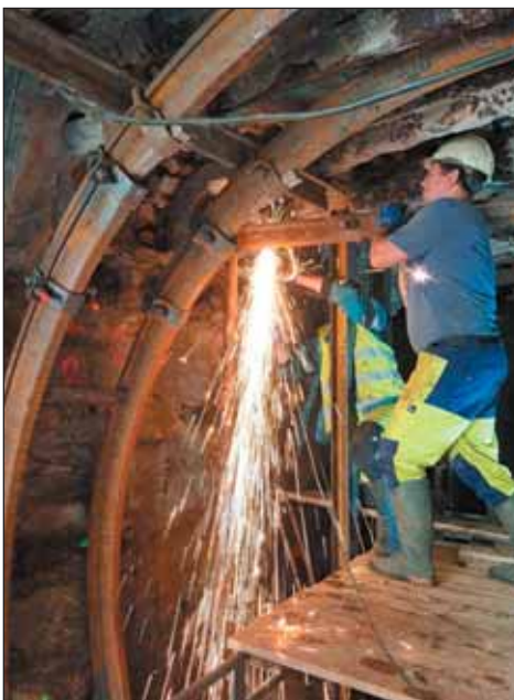
Obr. 5 Postup při osazování výztuže Huta Łabedy S.A. – V21
