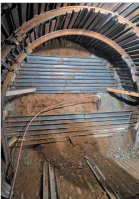
Obr. 3 Člňkování při ražbě Fig. 3 Face breasting during excavation
