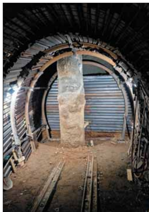
Obr. 4 Píla po věžovém jeřábu Fig. 4 Pile left over by a tower crane
