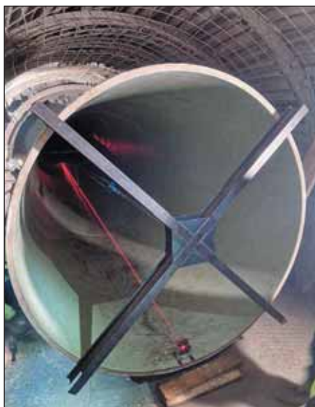
Obr. 9 Betonáž úseku štoly se zabudovaným potrubím SUPERLIT GRP
