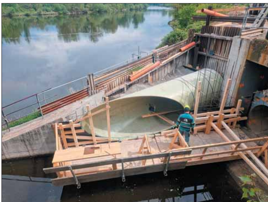
Obr. 5 Montáž sešikmeného potrubí na vyústním objektu Fig. 5 Mounting angled pipes at the outflow object
