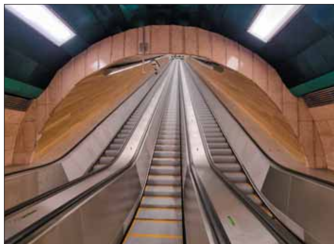
Obr. 4 Eskalátorový tunel po dokončení Fig. 4 Escalator tunnel after completion
