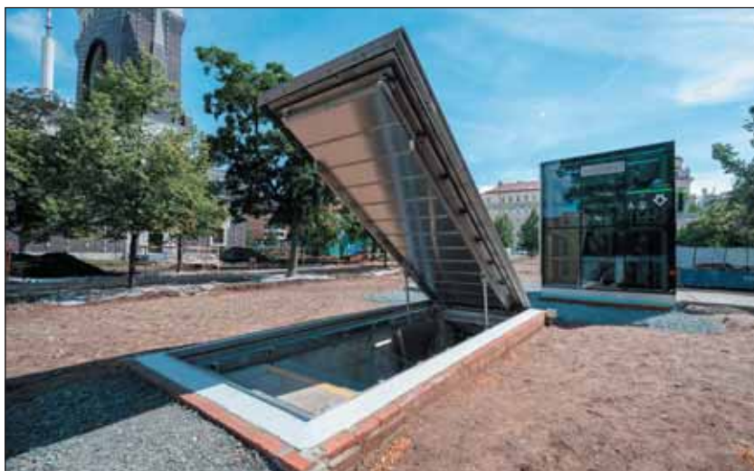
Obr. 11 Zaústění únikové cesty s poklopem na úrovni terénu Fig. 11 Outlet of the emergency exit with hatch at ground level
