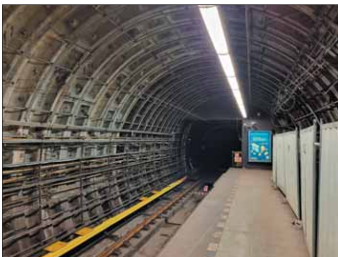
Obr. 1 Odstrojená stanice před sanací ostění Fig. 1 Stripped-down station before lining repair
