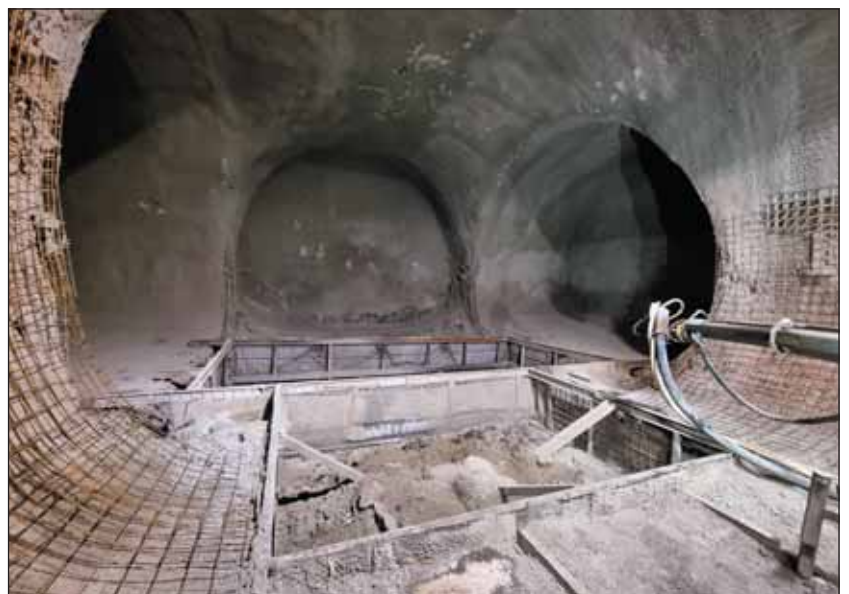
Obr. 7 Osazení ohlubňových rámců šachet Š2 Fig. 7 Installation of collar frames for shafts Š2
