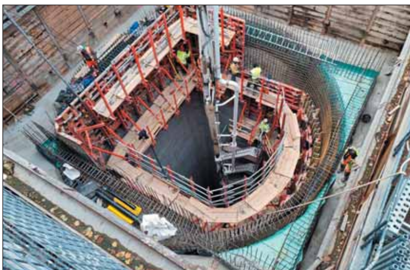
Obr. 9 Betonáž sekundárního ostění v Š1 Fig. 9 Concreting of secondary lining in shaft Š1
