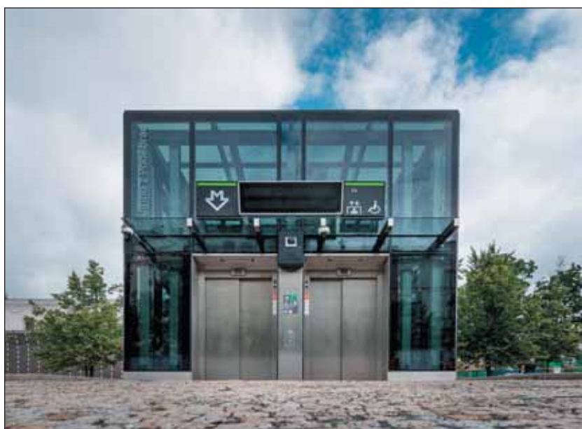
Obr. 12 Pohled na dokončený kiosk výtahů Fig. 12 View of the completed elevator kiosk
