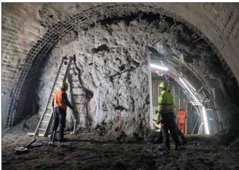
Obr. 8 Prorážka do stanice – řezání čelní stěny diamantovým lanem Fig. 8 Breakthrough into the station – cutting of the front wall with a diamond wire
