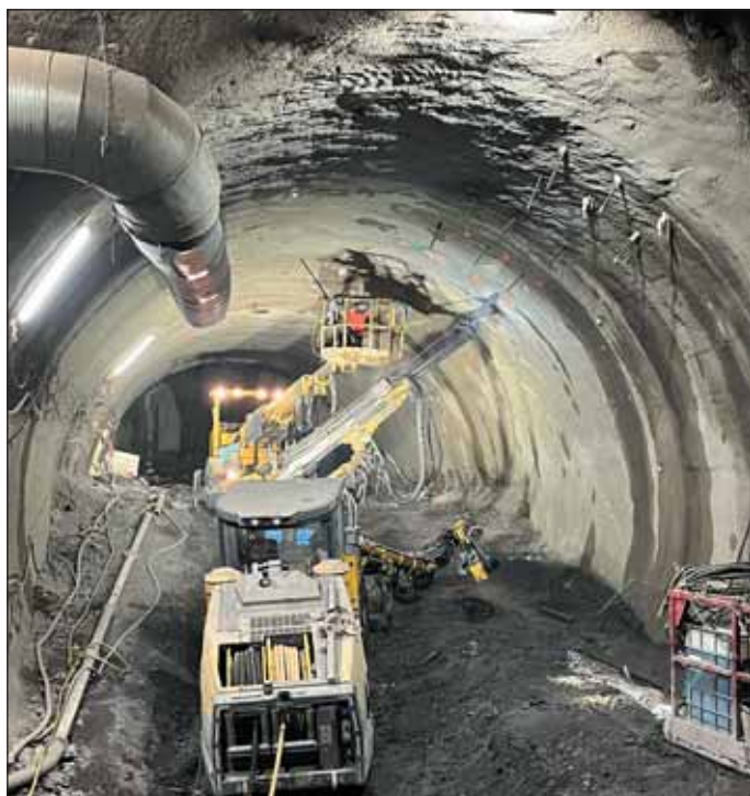
Obr. 3 Realizace kompenzačních injektáží Fig. 3 Realization of compensation grouting
