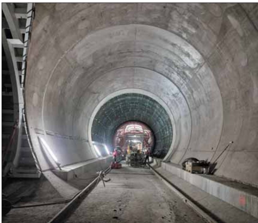
Obr. 7 Sekundární ostění staničního tunelu Fig. 7 Secondary lining of the station tunnel
