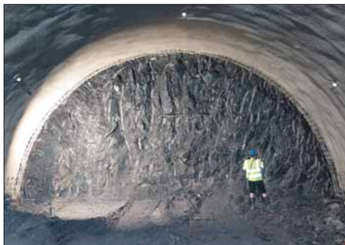
Obr. 2 Čelba kaloty staničního tunelu v bohdaleckých břidlicích (ordovik)
