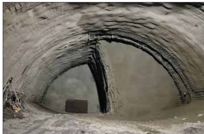
Obr. 4 Dílčí členění profilu kaloty TGT Fig. 4 Sequencing of the profile of the TGT heading
