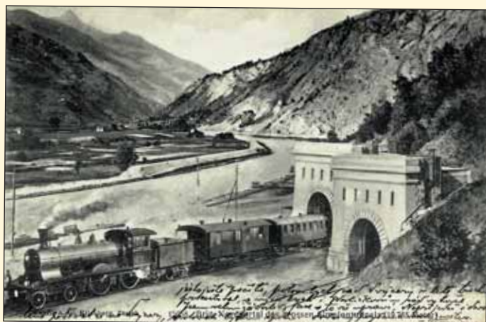
Obr. 6 Brig. Severní portál velkých Simplonských tunelů (19 755 metrů). Werli A. G., Kilenberg, Zürich. 1906 [sbírka autorů].
