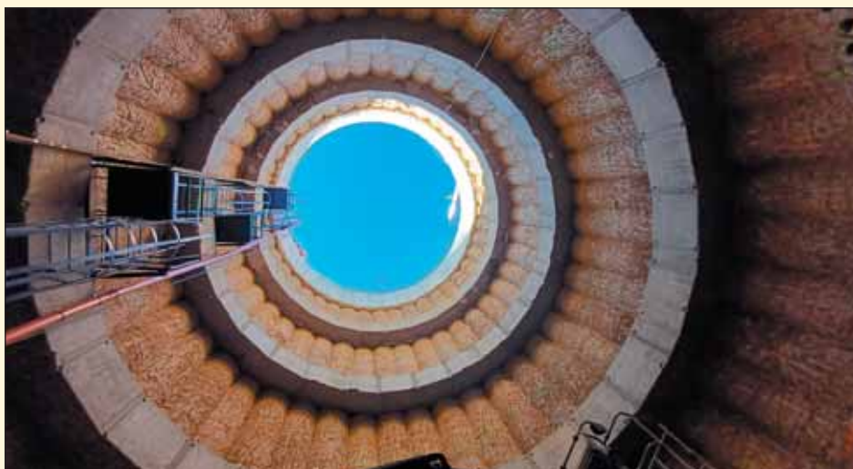
Obr. 4 Těžní šachta na průzkumné štolě VMO Vinohrady Fig. 4 Excavation shaft at the VMO Vinohrady exploration gallery
