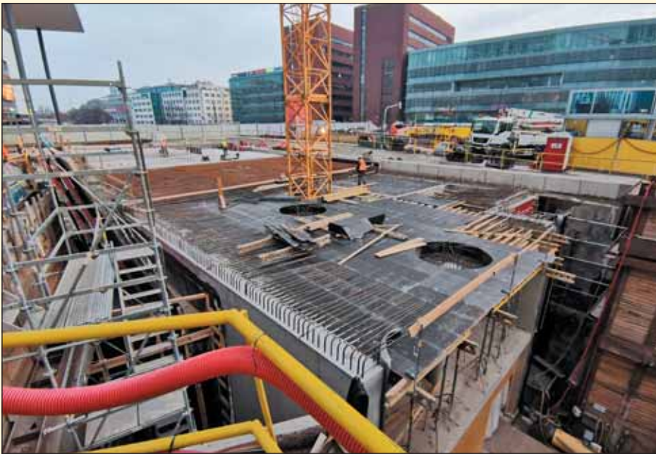
Obr. 3 Železobetonová konstrukce vestibulu Arkády Fig. 3 Reinforced concrete structure of the Arkády entrance hall
