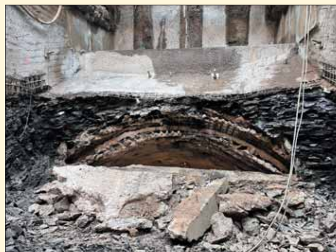
Obr. 2 Prorážka eskalátorového tunelu Fig. 2 Breakthrough of the escalator tunnel
