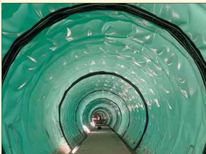
Obr. 1 Ražený jednokolejný tunel spojky C–D, provádění hydroizolace Fig. 1 Excavated single-track tunnel of the C–D interchange, waterproofing
