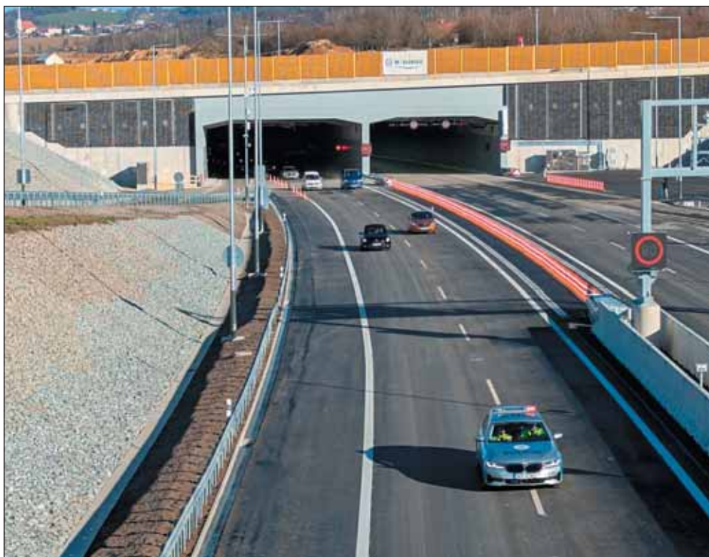
Obr. 12 Dokončený kaplický portál při uvedení do provozu Fig. 12 Completed Kaplický portal during commissioning
