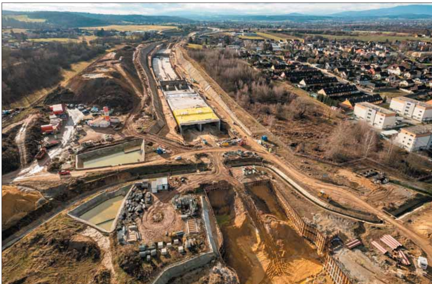
Obr. 10 Rozestavěný tunel – pohled od Prahy, leden 2023
