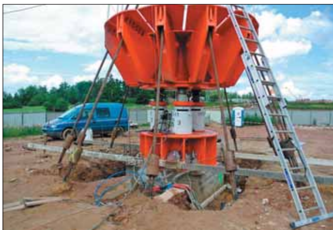
Obr. 5 Zatěžovací zkouška zkušební lamely Fig. 5 Load test of the test lamella
