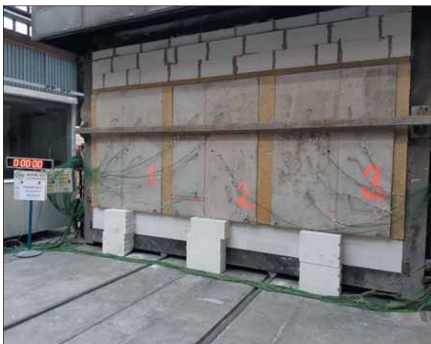
Obr. 9 Požární zkouška – provedení Fig. 9 Fire test – execution
