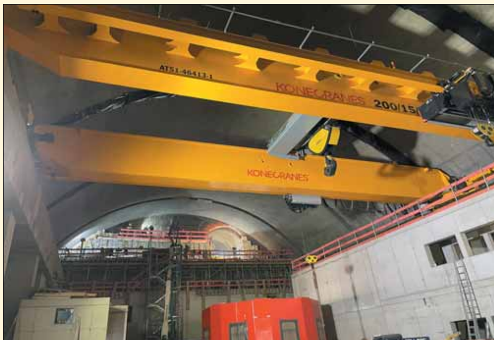
Obr. 3 Stavební rozpracovanost objektu hydroelektrárny na projektu Kühtai Fig. 3 Construction progress of the hydroelectrical power plant at the Kühtai project
