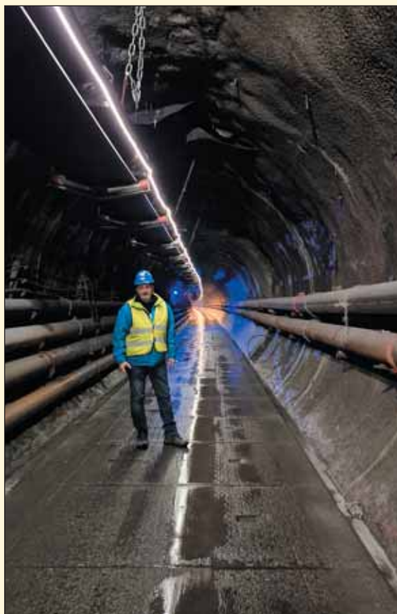
Obr. 4 Začátek raženého profilu tunelu strojem TBM na projektu Kühtai Fig. 4 The beginning of the tunnel's TBM-driven profile at the Kühtai project
