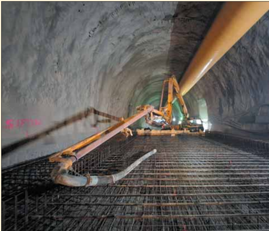
Obr. 3 Příprava na betonáž spodnej klenby v tuneli Okruhliak Fig. 3 Preparation for invert concrete casting in the Okruhliak tunnel
