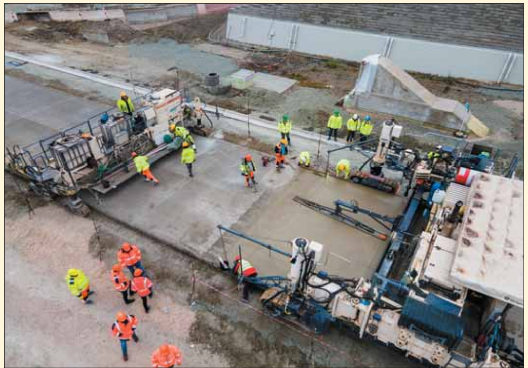
Obr. 5 Betonáž krytu vozovky na západnom portáli tunela Višňové
