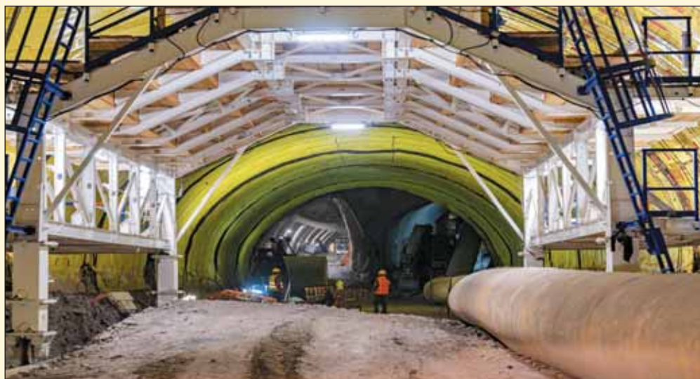
Obr. 2 Pohled na provádění hydroizolací Fig. 2 A look at the waterproofing process
