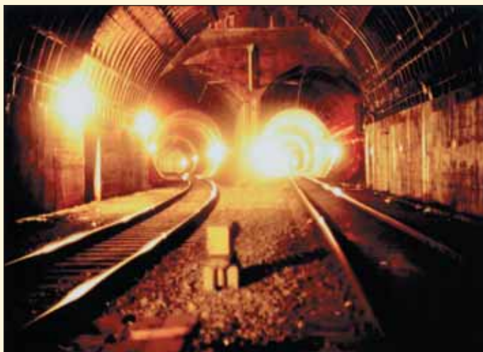
Obr. 7 Přechod rozpletu na dva jednokolejné tunely
