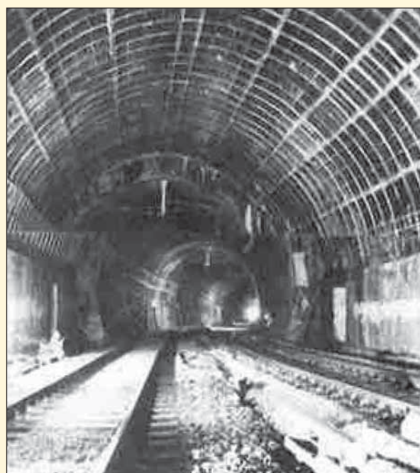
Obr. 6 Napojení rozpletu na starý Vinohradský tunel III Fig. 6 Connection of the junction to the old Vinohrady III tunnel
