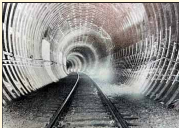
Obr. 8 Východní jednokolejný tunel
