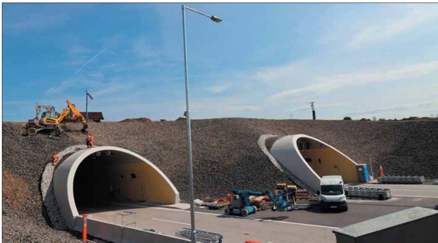
Obr. 3 Realizácia definitívneho južného portálu
