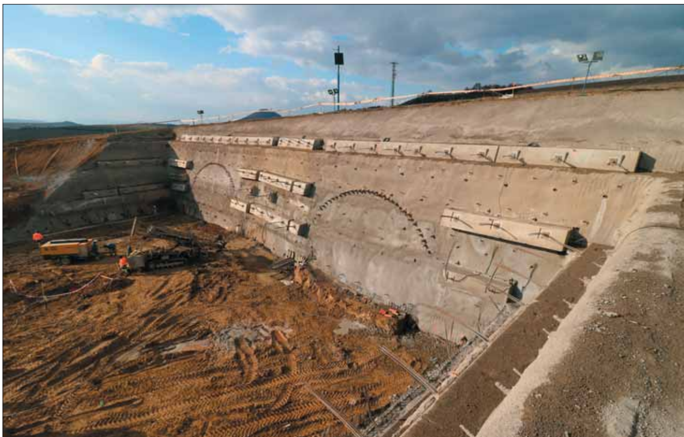
Obr. 2 Realizácia hrubých terénnych úprav južného portálu Fig. 2 Realization of hard landscaping of the southern portal
