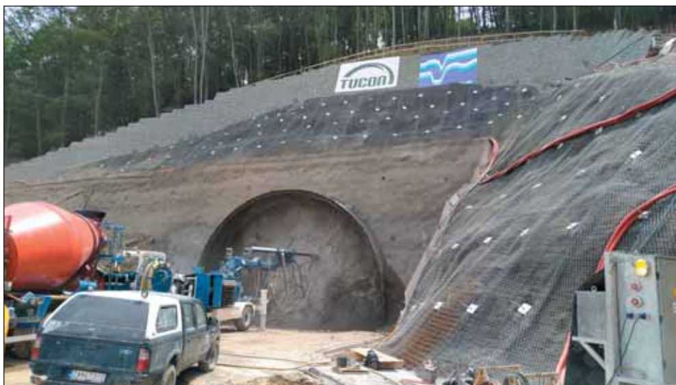
Obr. 7 Realizácia hrubých terénnych úprav severného portálu Fig. 7 Realization of hard landscaping of the northern portal
