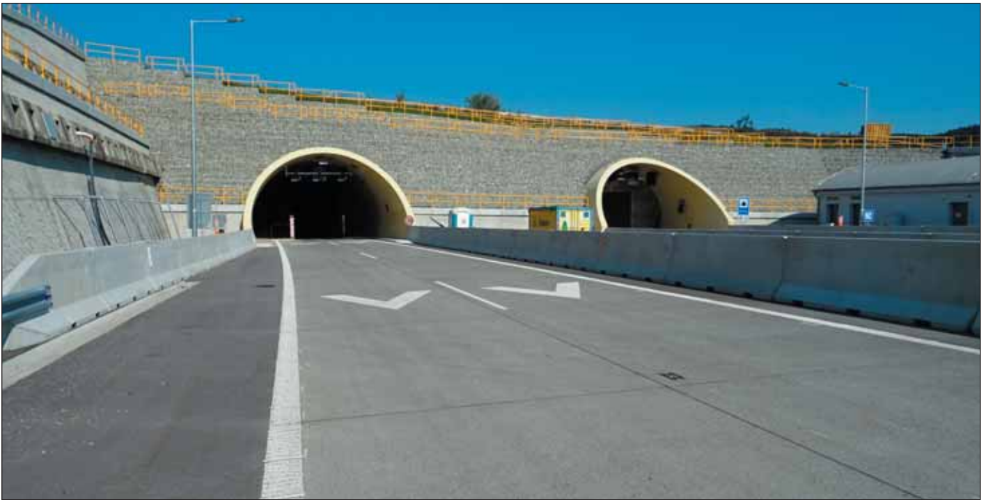
Obr. 1 Vozovka na východnom portáli tunela Ovčiarско, Diaľnica D1 Hričovské Podhradie – Lietavská Lúčka (CBK v jazdných pruhoch a AC kryt v odstavnom pruhu)
