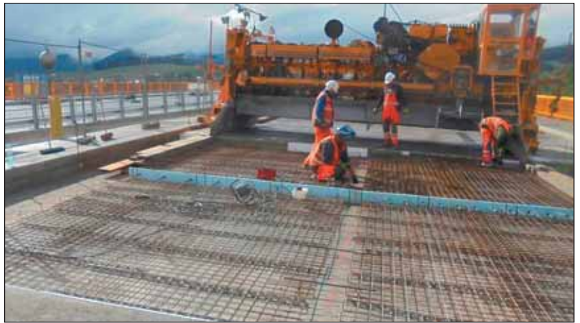
Obr. 5 Diaľnica D1 Hričovské Podhradie – Lietavská Lúčka, prechodový úsek pri tuneli Žilina – vystuženie CBK pri prechode na mostný objekt
