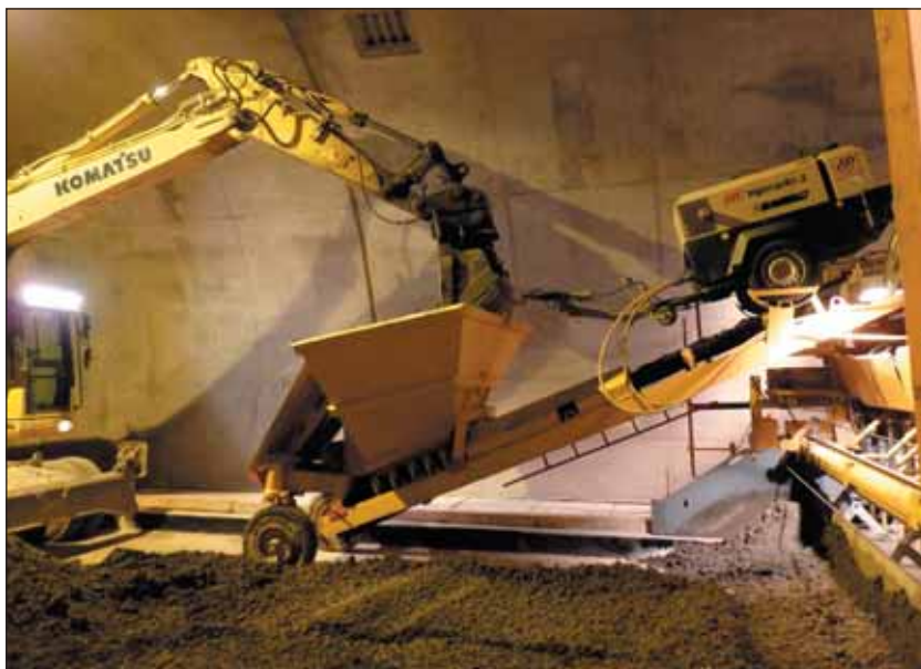
Obr. 4 Tunnel Svrčinovec – betonáž hornej vrstvy krytu cementobetónovej vozovky Fig. 4 Svrčinovec Tunnel – concreting of the upper layer of the cement concrete pavement
