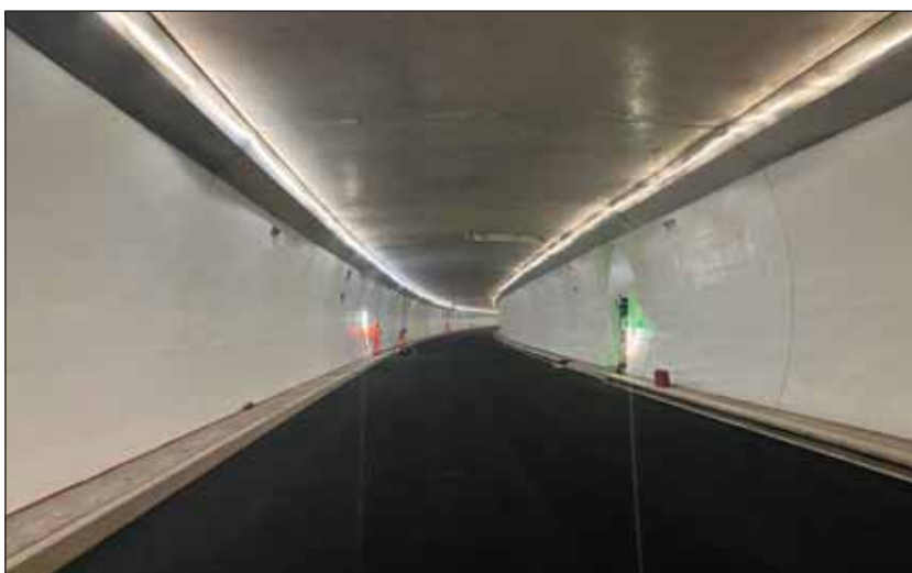
Obr. 6 Vozovka s asfaltobetónovým krytom na diaľnici A1 v tuneli Gubristtunnel (Švajčiarsko), a) realizácia ložnej vrstvy AC krytu, b) zhotovená vozovka s AC krytom
