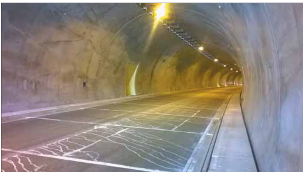
Obr. 2 Cementobetónová vozovka v tuneli Svrčinovec po realizácii škár
