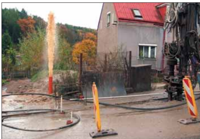
Obr. 5 Sanační vrty dobývkového komína v podloží městské komunikace a v pásnu vlivu nové výstavby v Horním Slavkově
