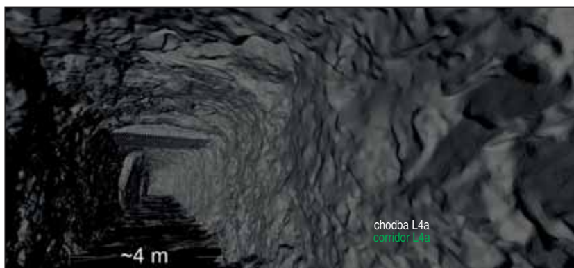
Obr. 7 Model chodby L4a získaný z laserového skenování, detail Fig. 7 Model of corridor L4a obtained from laser scanning, detail
