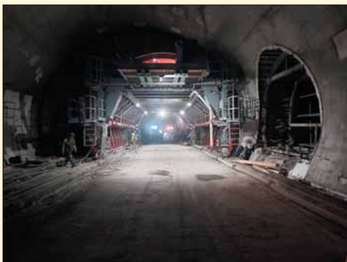
Obr. 4 Betonáž núdzového zálivu NZ2 v tuneli Čebrať Fig. 4 Concreting of emergency lay-by NZ2 in the Čebrať tunnel
