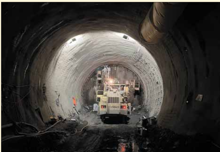
Obr. 2 Pohled na ražby staničního tunelu stanice Olbrachtova Fig. 2 A view of excavation of Olbrachtova station tunnel
