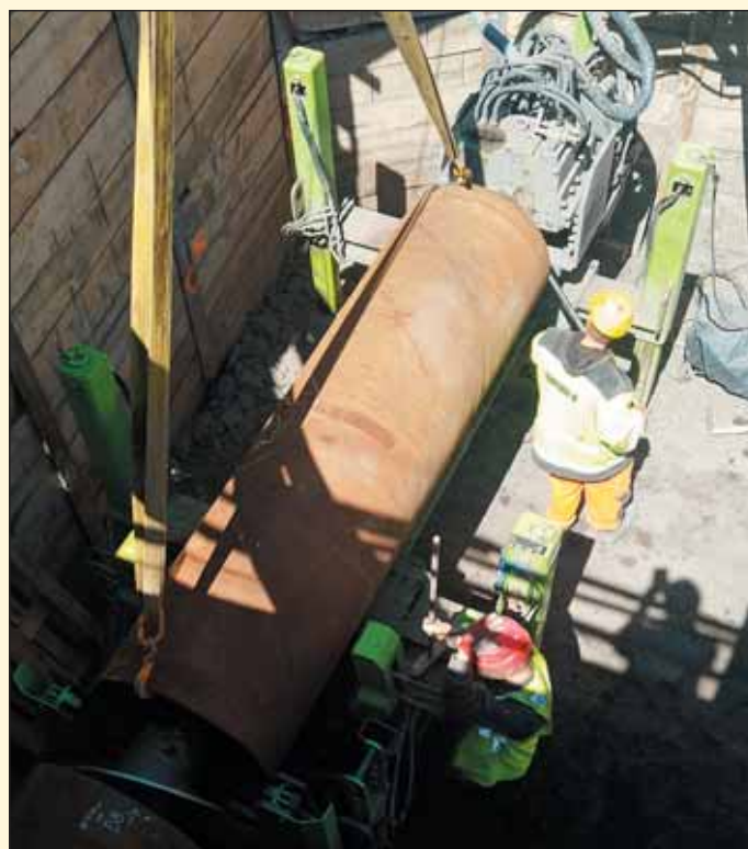
Obr. 2 Výstavba kabelových ductů metodou horizontálního přiklepevého vrtání v Praze na Balabence
