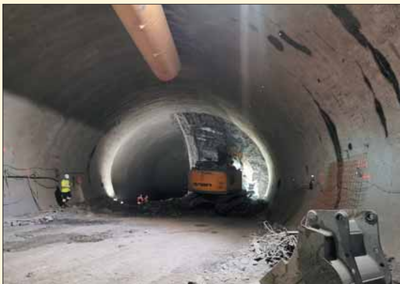
Obr. 1 Pohled na ražby obrátových kolejí stanice Pankrác Fig. 1 A view of excavation for turn-back tracks of Pankrác station
