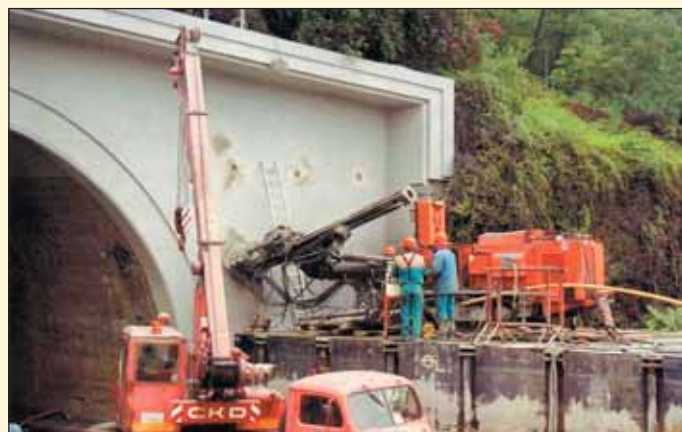
Obr. 6 Sanace jižního portálu po povodni v roce 2002 Fig. 6 Stabilisation of southern portal after the flood in 2002
