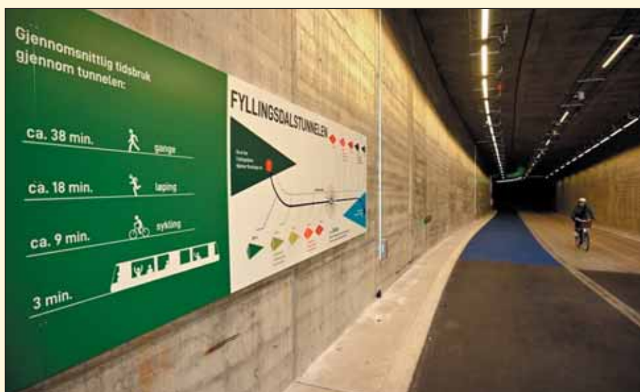
Obr. 5 Informativně-propagační panely v cyklotunelu Fyllingsdalen Fig. 5 Informative and promotional panels in the Fyllingsdalen cycle tunnel
