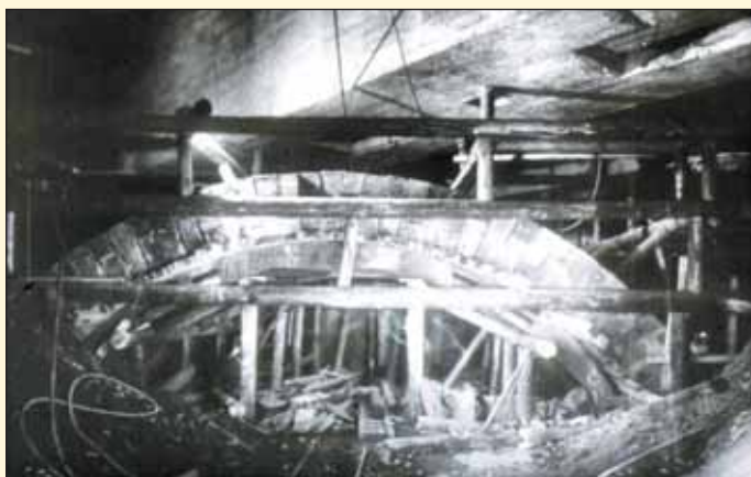
Obr. 5 Podchycení budovy zemědělského muzea železobetonovými nosníky Fig. 5 Underpinning of Museum of Agriculture with reinforced concrete beam
