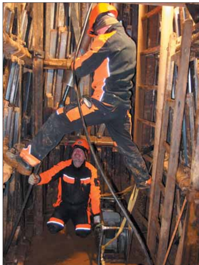
Obr. 10 Průzkumné sondy dynamické penetrace v jámě KŠ1 Fig. 10 Exploration probes of dynamic penetration in the KŠ1 shaft
