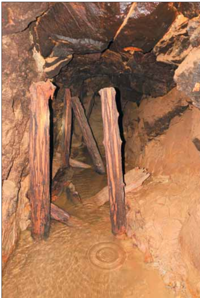
Obr. 12 Stav odvodňovací štoly Barbora před obnovou Fig. 12 The state of the Barbora drainage gallery before remediation
