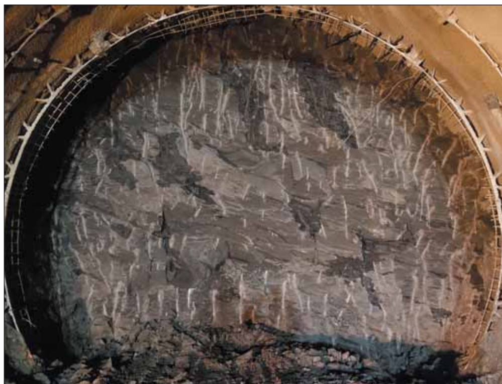
Obr. 3 Zdravé břidlice bohdaleckého souvrství na čelbě pravého jednokolejného tunelu
