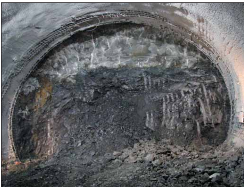
Obr. 7 Intruze tělesa masivní minety při ražbě dvoukolejného tunelu Fig. 7 Intrusion of a massive minette body during excavation of double-track tunnel
