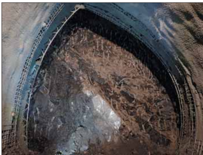
Obr. 4 Lavicovité polohy pískovců polyteichové facie v prostředí břidlic zastížené při ražbě dvoukolejného tunelu
