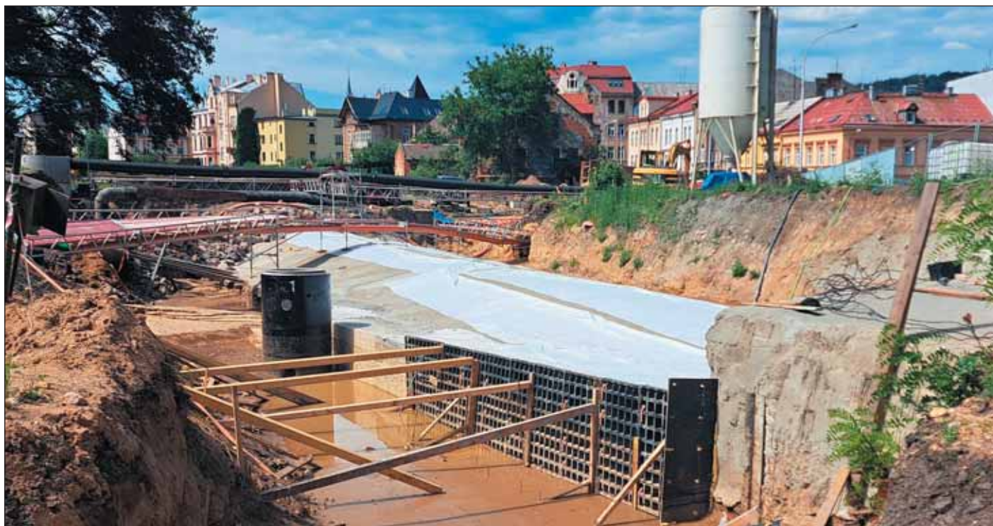
Obr. 8 Pohled na izolovaný rub klenby Loubského tunelu
