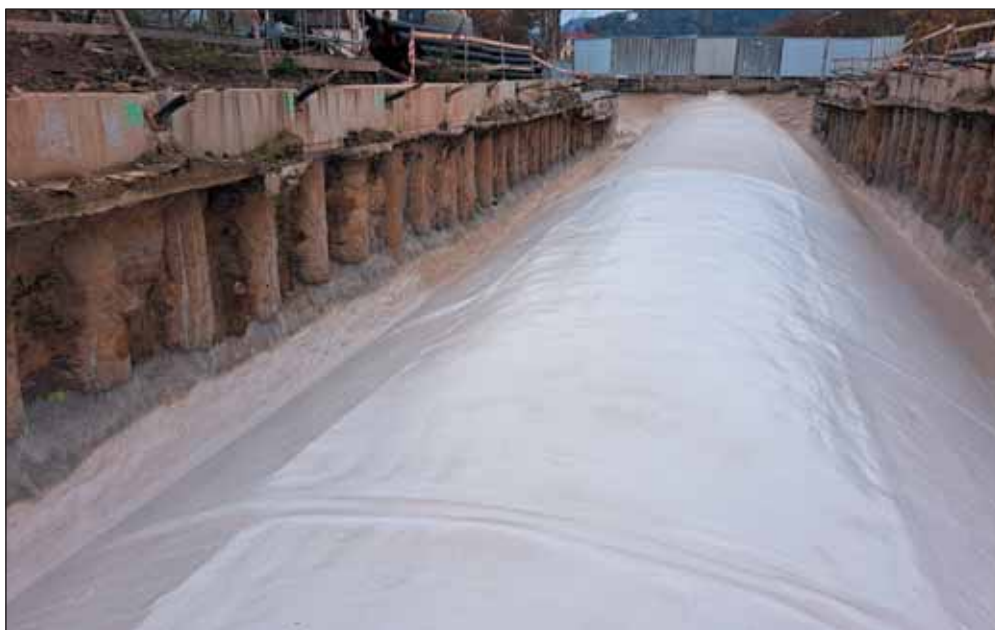
Obr. 4 Rubová stříkaná hydroizolační membrána nové klenby tunelu Fig. 4 Back side sprayed waterproofing membrane of the new tunnel vault
