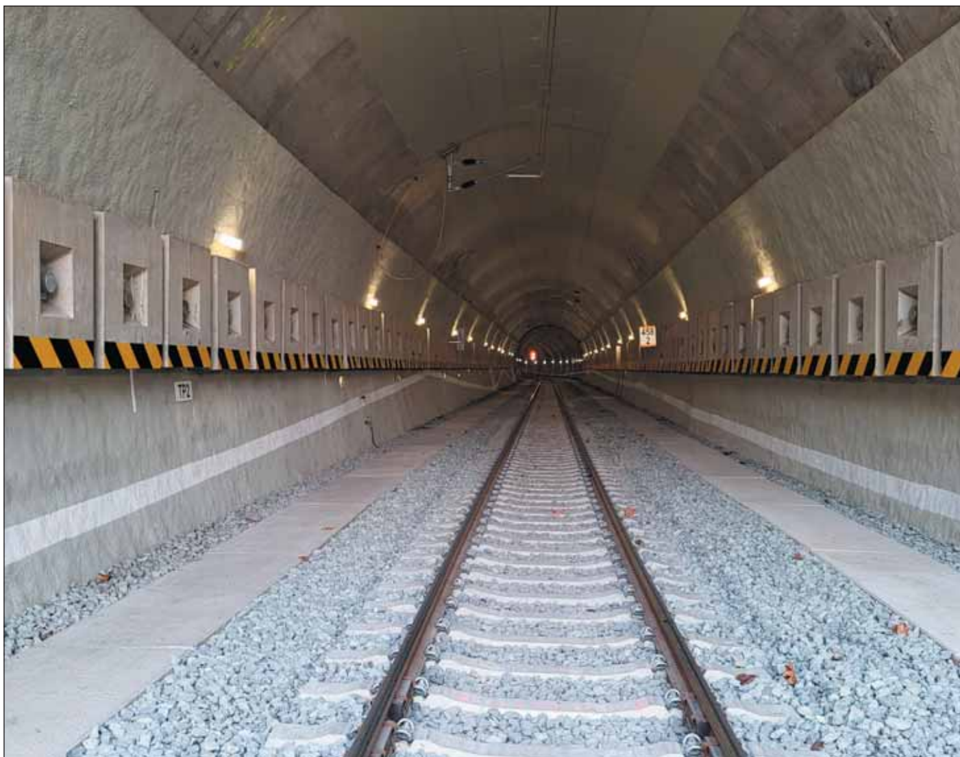
Obr. 7 Pohled do hloubené části Děčínského tunelu po rekonstrukci Fig. 7 View of the cut and cover part of the Děčínský Tunnel after reconstruction
