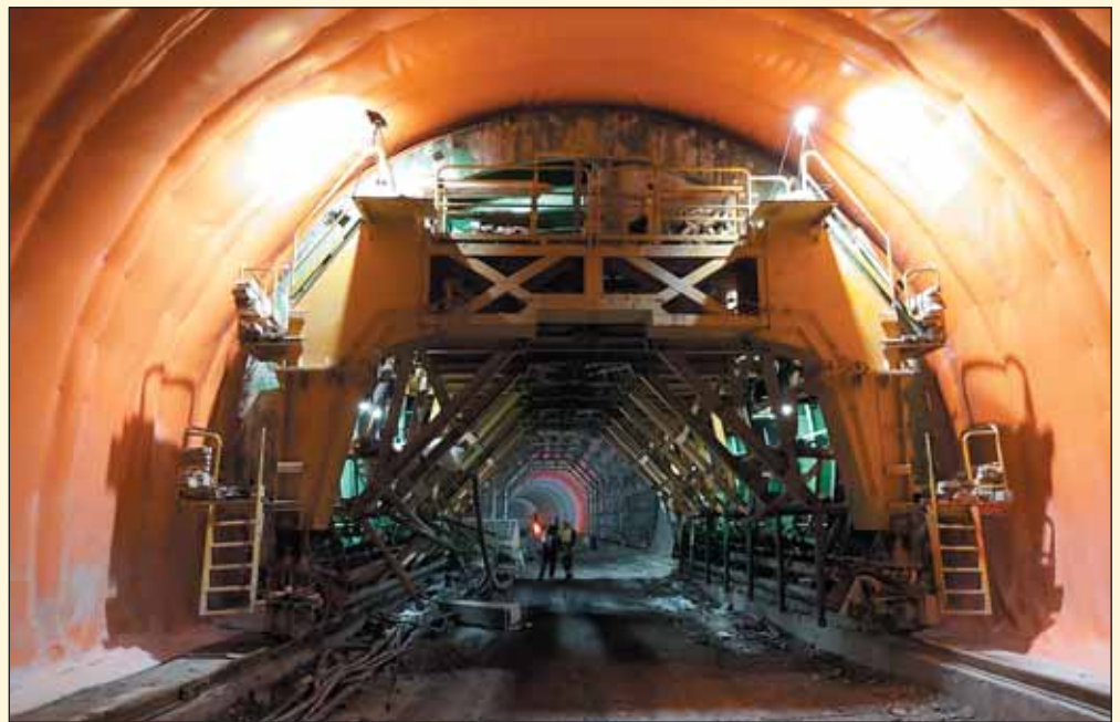
Obr. 5 Debniaci voz v tuneli Čebrať Fig. 5 Tunnel form traveller for the Čebrať tunnel
