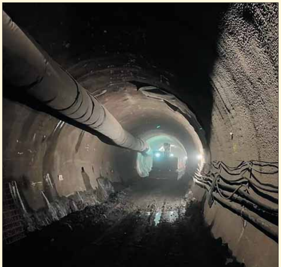
Obr. 2 Ražba tunelové spojky C-D Fig. 2 Excavation of C-D linking tunnel
