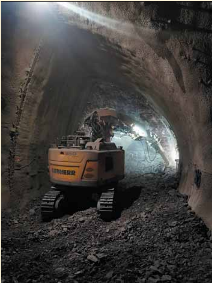
Obr. 1 Ražba části profilu kaloty obrátových kolejí směrem do stanice Pankrác Fig. 1 Excavation of part of the top heading of the tunnel excavation for turn-back rails to Pankrác station
