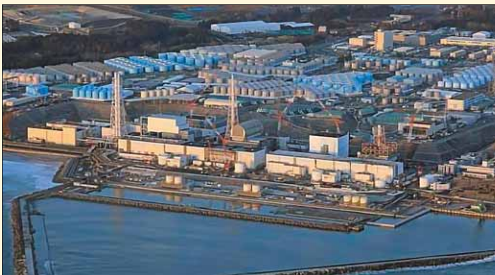
Obr. 1 Jaderná elektrárna Fukušima 1
