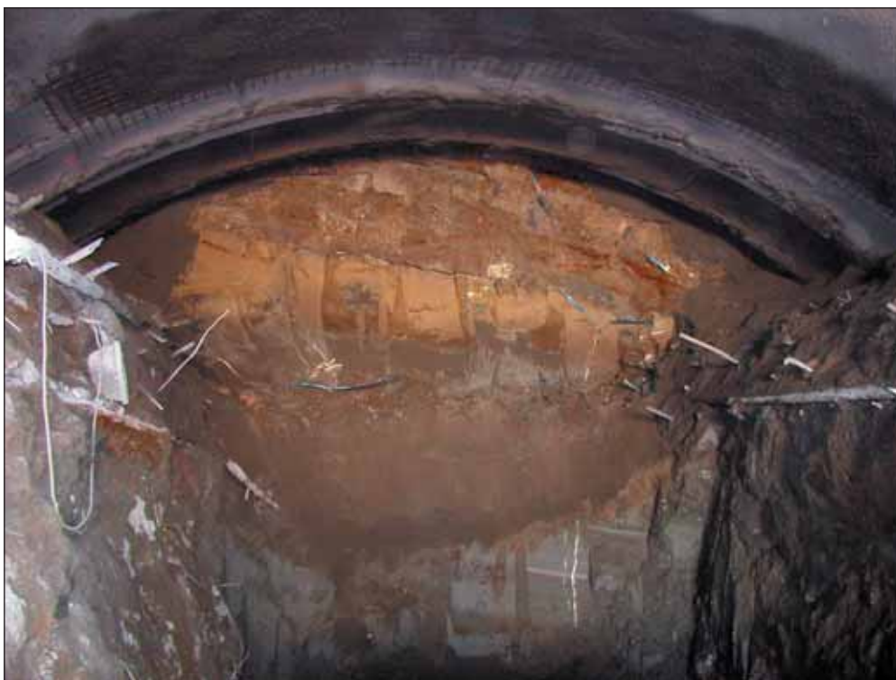
Obr. 9 Proinjektované zvodnělé nesoudržné zeminy v kalotě (lokality Brno, Královopolský tunel)
