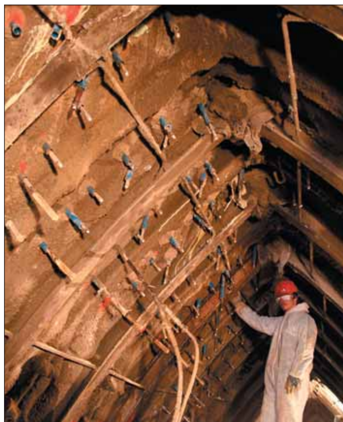
Obr. 10 Radiální injekční vrty vystrojené injekčními trubkami (lokality Brno, Královopolský tunel)
