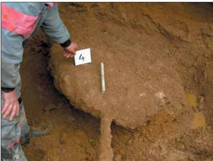
Obr. 7 Odtěžené těleso proinjektované zeminy – tzv. geokompozit (lokality Brno, Královopolský tunel) Fig. 7 Extracted body of grouted soil – so called geocomposite (locality Brno, Královopolský tunnel)
