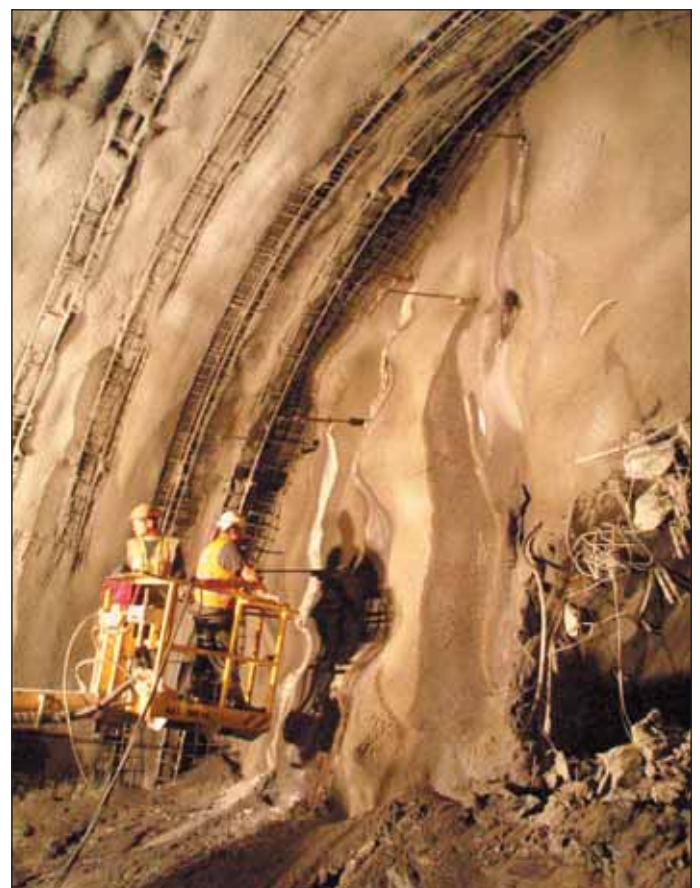
Obr. 5 Provádění injektážních prací pryskyřicí CarboPur WF v kalotě raženého tunelu (lokality Královská obora, TKB)
