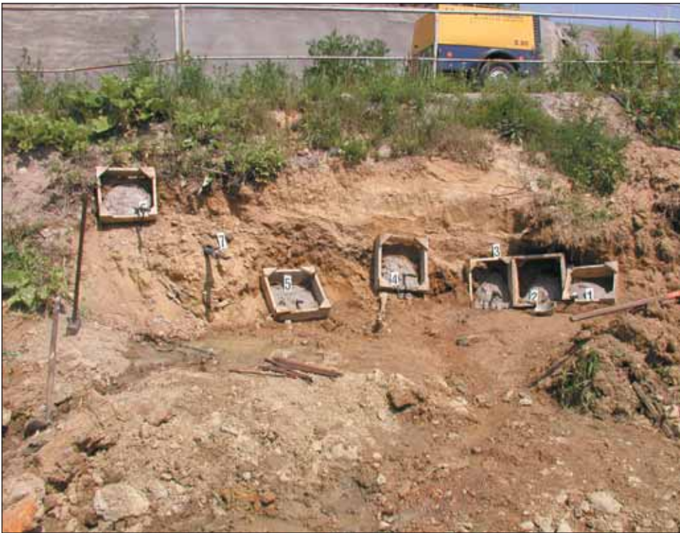
Obr. 6 Zkušební pole s injekčními vrti č. 1–7 ve vrstvě zvodněných štěrkopísků (lokality Brno, Královopolský tunel) Fig. 6 Test field with boreholes No. 1–7 in aquiferred gravel sands (locality Brno, Královopolský tunnel)
