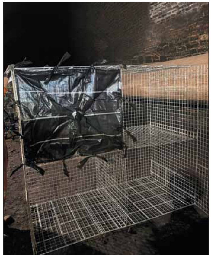
Obr. 6 Gabionový koš s instalovaným vakem Fig. 6 Gabion basket with installed filling bag
