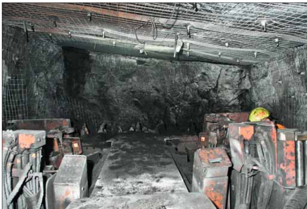
Obr. 1 Pohled na čelbu přes řezný orgán kombajnu Bolter Miner Fig. 1 View of the face from the cutter head of Bolter Miner
