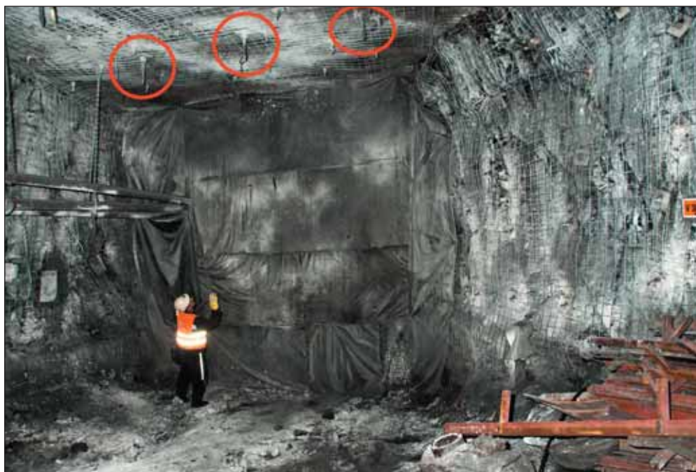
Obr. 3 Důlní dílo s využitím samostatné svorníkové výztuže a pramencových kotev (vyznačeno červeně) ve stropě v místech tektonických poruch a nesoudržného nadloží
