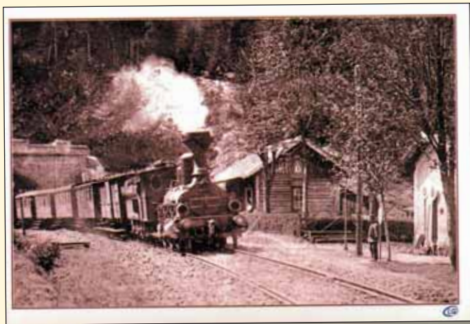
Obr. 1 Reprodukce pohlednice z roku 1912 zachycující osobní vlak s lokomotivou 26.02 (později u ČSD řada 233.1) při výjezdu ze severního portálu tunelu na šumavském Špičáku. Sběrka Martin a Pavel Reisser. Železniční spolek v Rokycanech. Po roce 2000 [sbírka autorů].
