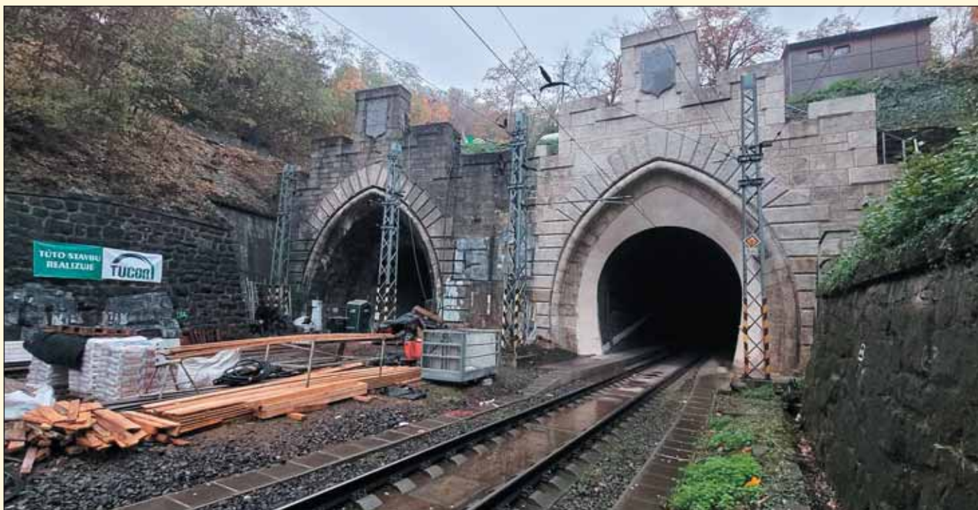
Obr. 6 Lamačský portál Bratislavských tunelov, vpravo tunel č. 1, vľavo tunel č. 2 Fig. 6 Lamač portal of the Bratislava tunnels, tunnel No. 1 for the right, tunnel No. 2 for the left
